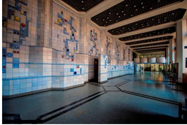
Resim 20: TEK Genel Müdürlüğü Binası, giriş katı Modüler pano uygulaması, 1500 m 2 .
