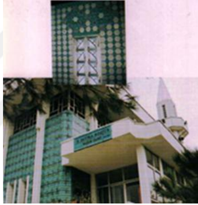
Resim 17: Çan'daki Hacı Fatma Bodur Camii, iç ve dış görünüm seramik uygulaması.
