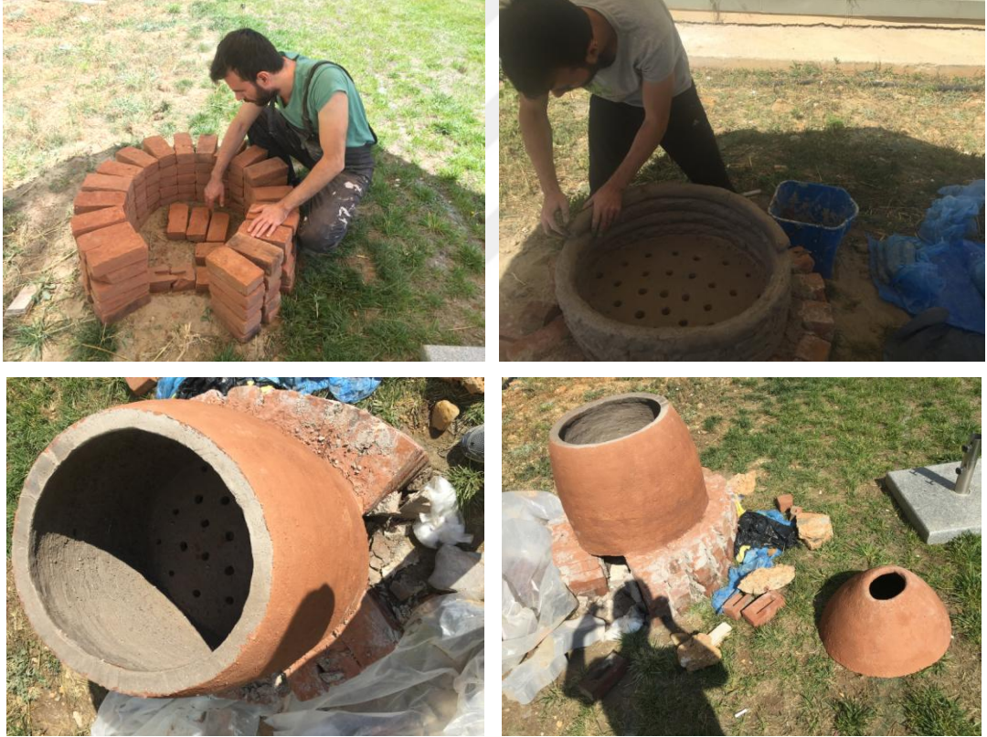
Resim 80-83: Ateşlik bölümü ve fırın formun yapım aşaması. Fotoğraf: Okan Kılıçoğlu kişisel fotoğraf arşivi.
