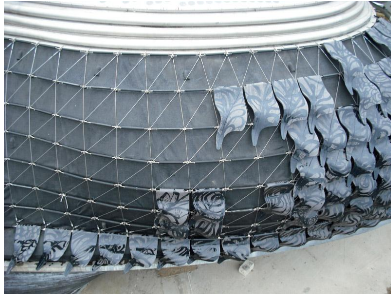
Resim 63: Seramik karoların montaj aşaması https://www.ruiz-geli.com/projects/inprogress/villa-nurbs (10.05.2019)
