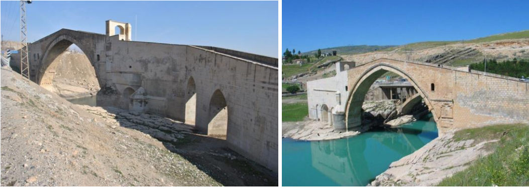
Resim 23: Silvan Malabadi Köprüsü Kuzey ve Güney Cephelerden Genel Görünüş
