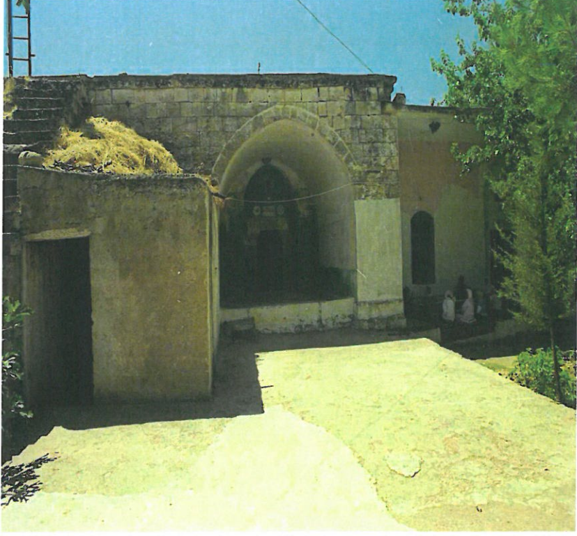
Resim 56 Halfeti Çekem Mahallesi Mescidi Kuzey Cephe
