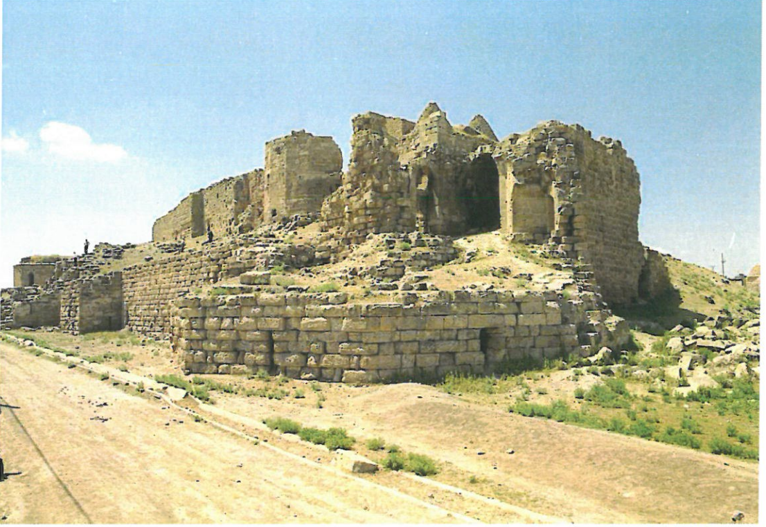
Resim 59 Harran Kalesi Kuzey-Doğu Cephesi
