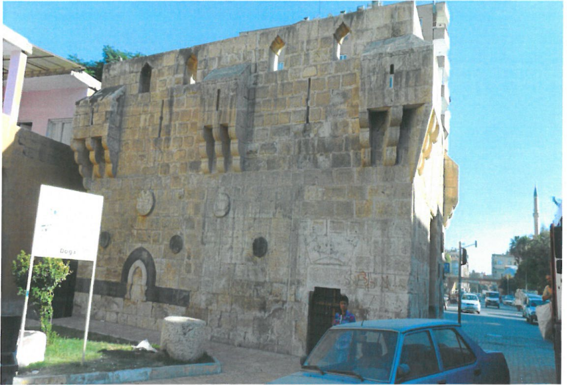
Resim 51 Birecik Alaburç Mescidi Kuzey Cephe Restorasyondan Sonra
