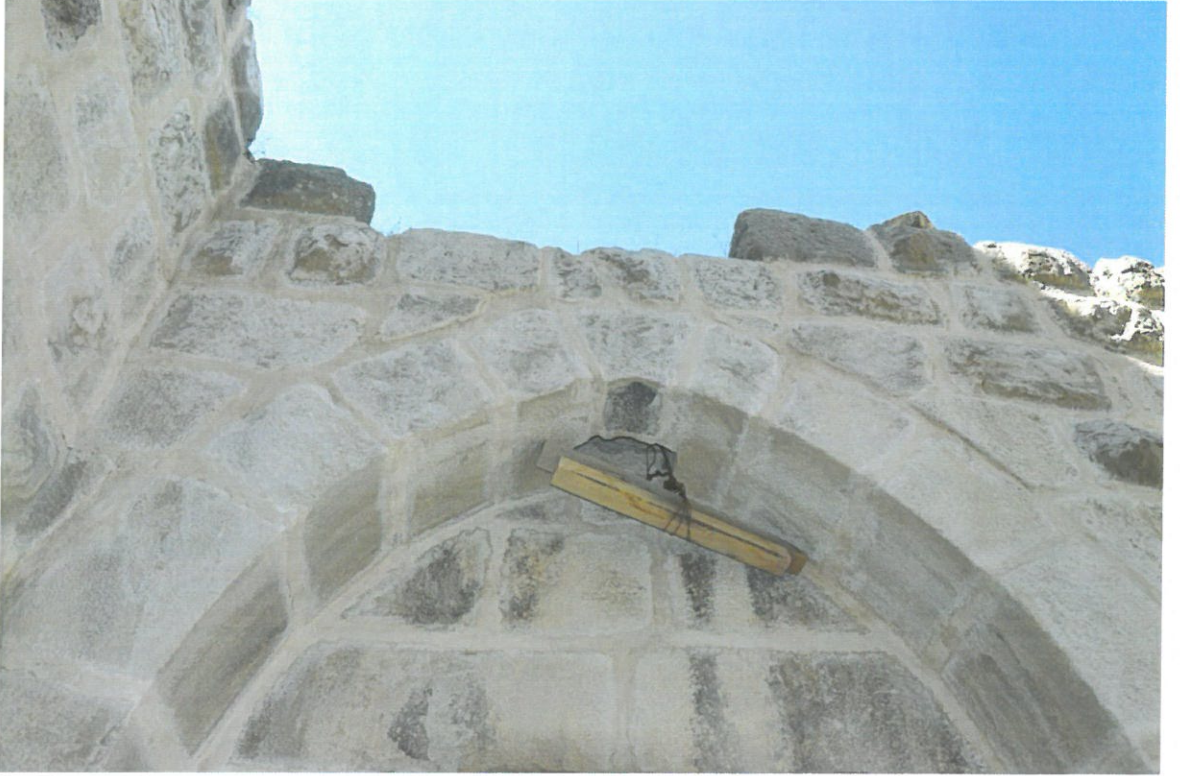
Resim 96 Yeni Kale Giriş Kapısı Yağ Dökme Açıklığı
