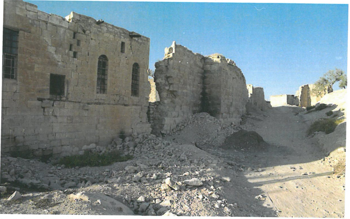
Resim 14 Birecik Kalesi Sur Duvarı
