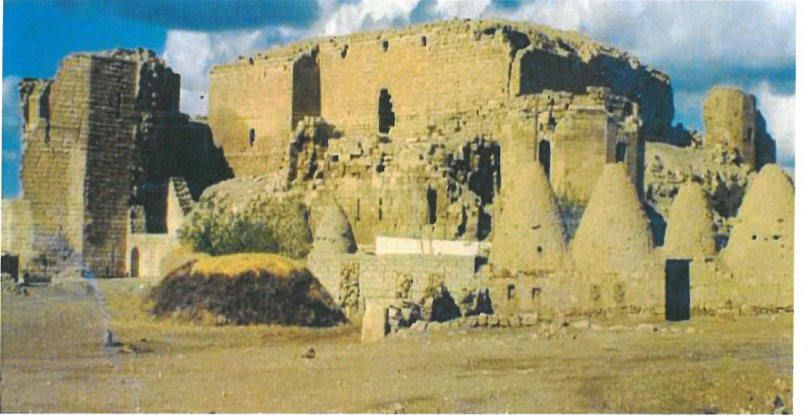
Resim 58 Harran Kalesi Güney Cephesi
