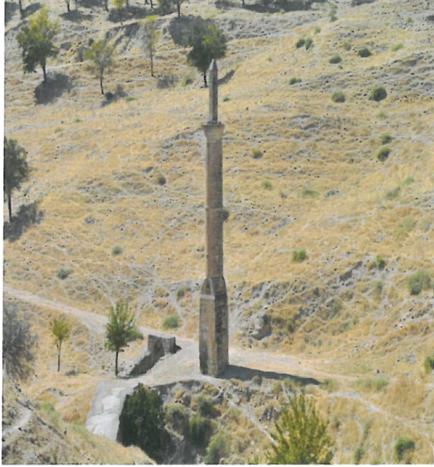
Resim 104 Eski Besni Girişindeki Minare
