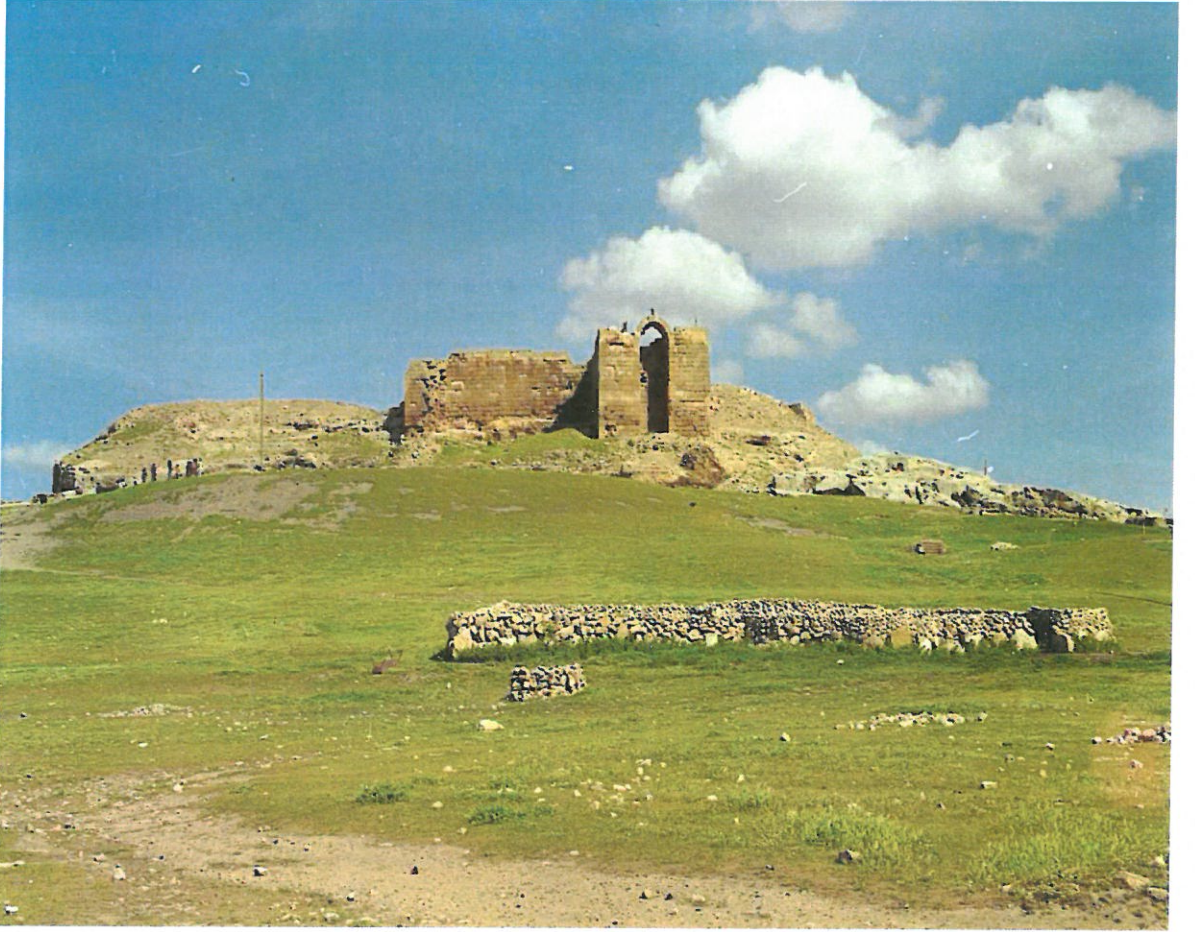
Resim 63 Çimdin Kale Batı Cephesi
