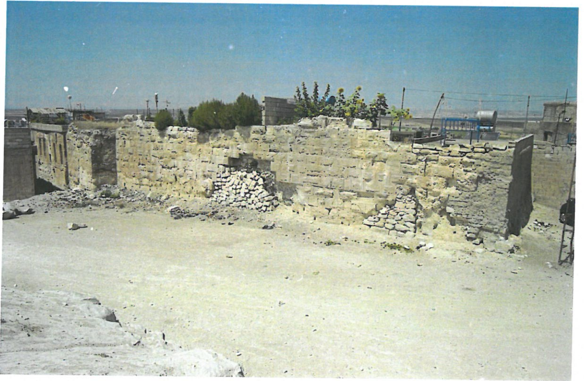
Resim 15 Birecik Kalesi Sur Duvarı
