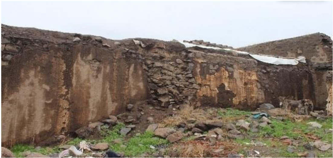
Foto 3: Kızıltepe şehir yerleşmesinin kuzeybatı kesiminde bulunan Kocalar köyünün üzerinde bulunduğu Üst Miyosen yaşlı bazaltlar yapı malzemesi olarak kullanılmaktadır.
