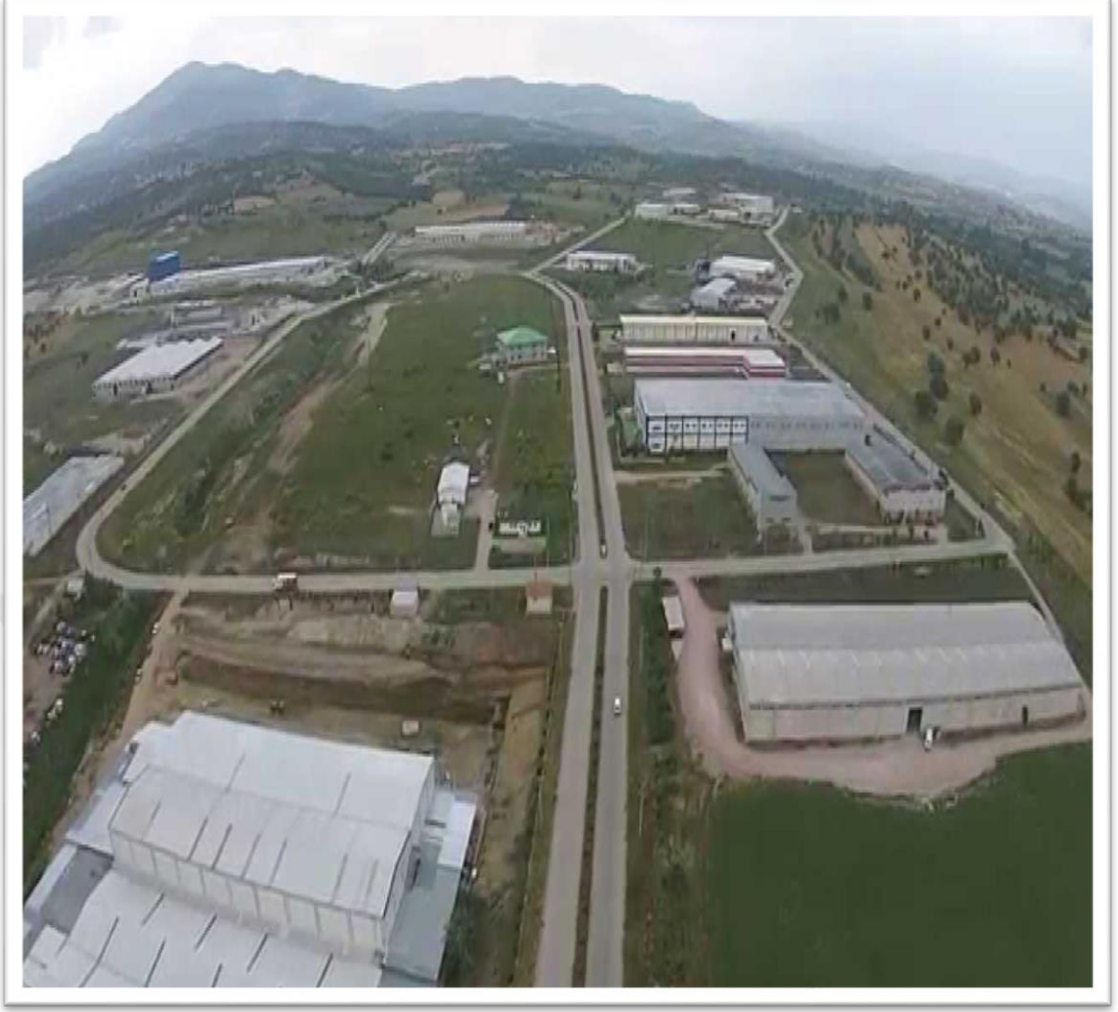
Foto 30: Gediz İlçesi OSB Kuş Bakışı Genel Görünümü
