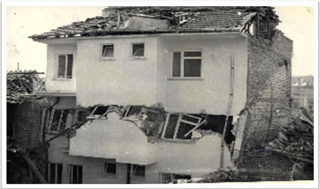
Foto 2: Gediz Deprem Sonrası Yıkılmış Ev Görüntüsü
