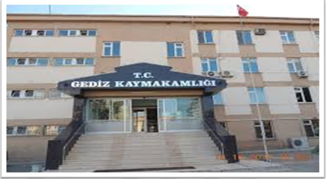
Foto 16: Gediz İlçesi Kaymakamlık Binası
