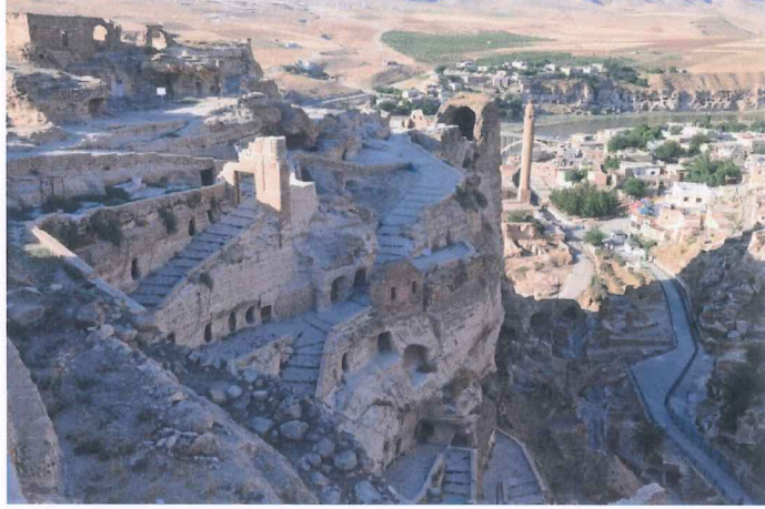
Resim 18: Kale'nin doğu cephesinde yer alan kapılar ve dükkânlar
