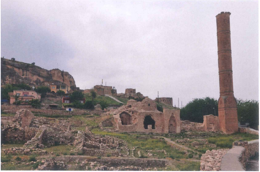
Resim 44: Sultan Süleyman Cami (Külliyesi)
