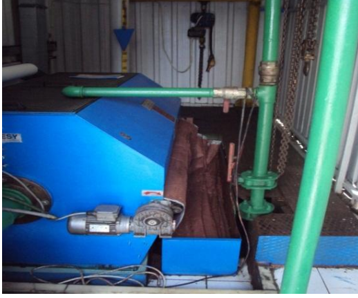
Şekil 4.5 Bant Filtre Sistemi
