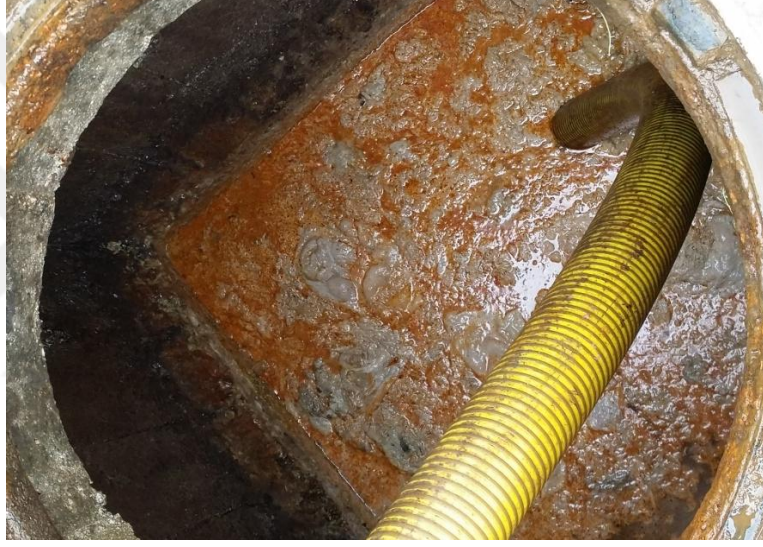
Şekil 4.23. Yemekhane yağ tutucu öncesi rögarda biriken yemek artıklarına ait görüntü
