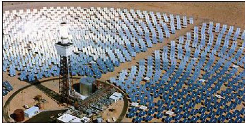
Şekil 2.1.11 Heliostat sistem [5]
