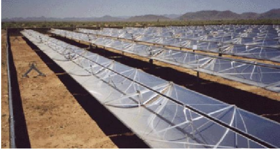
Şekil 2.1.4 Parabolik oluklu toplayıcı [5]
