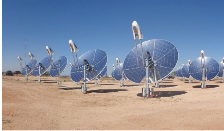
Şekil 3.5.6 Infinia şirketine ait olan Stirling motor [18]
