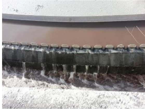
Resim 3.4 Kimyasal Arıtma Sonrası Numune Alım Noktası (2. Nokta)
