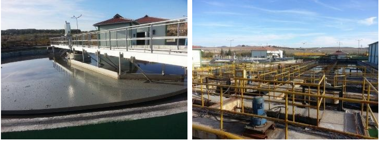
Resim 3.3 Kimyasal Arıtma İşlemlerinin Yapıldığı Bölümler
