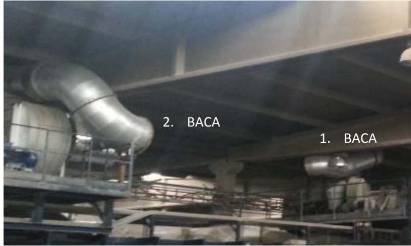
Resim 6.5. İki temiz sıcak hava bacasının birleşimi
