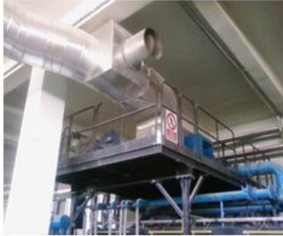
Resim 4.3. Soğutma havasının değerlendirmesine bir örnek
