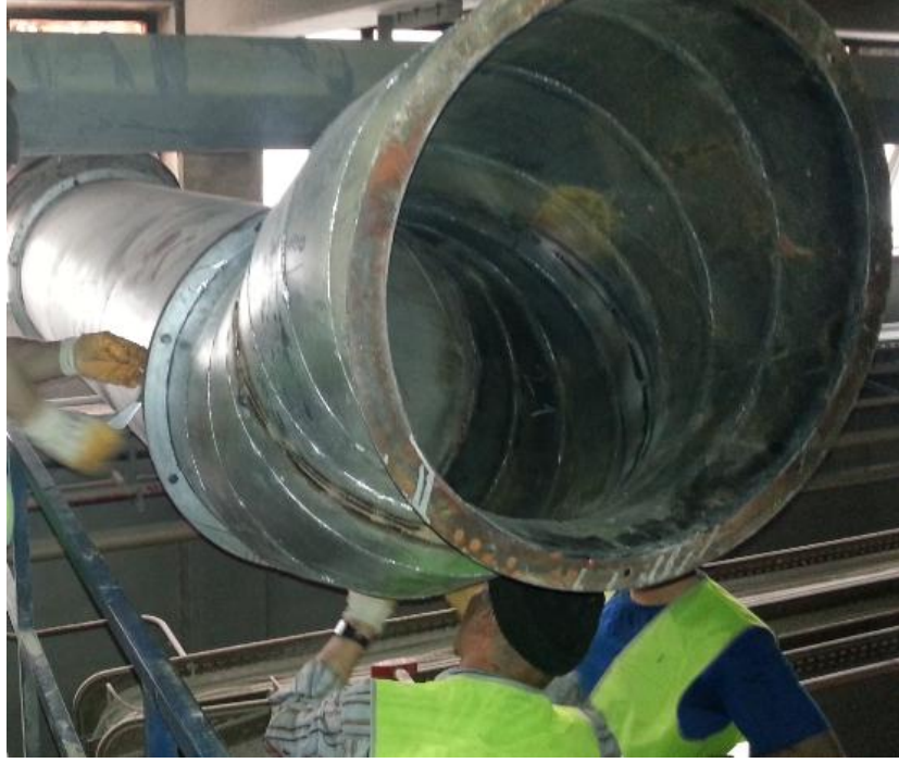
Resim 6.4. Temiz sıcak hava bacası çıkış hattı
