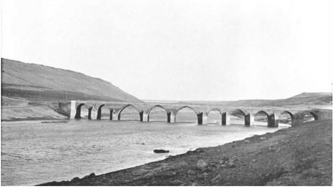
Fotoğraf 17: Diyarbakır Ongözlü Köprü 664
