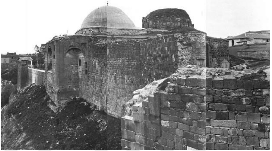
Fotoğraf 46: Diyarbakır İçkale St. George Kilisesi 693
