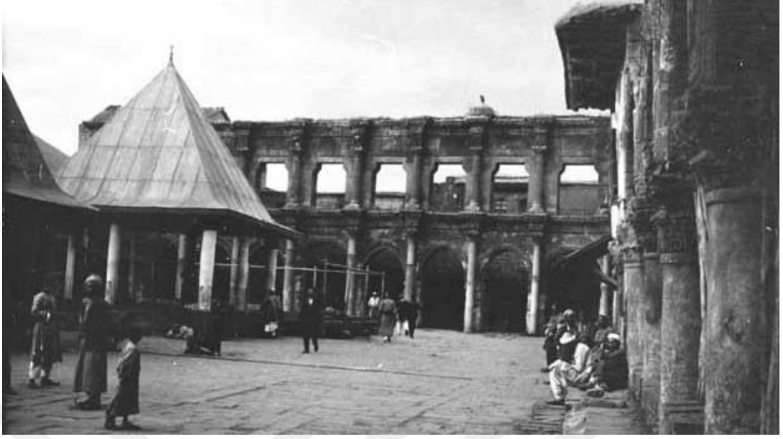
Fotoğraf 20: Diyarbakır Ulu Camii avlusu 667
