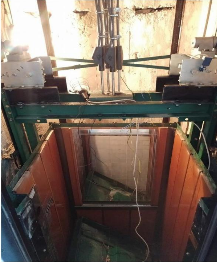
Şekil 4.25 Süspansiyon üzerine yardımcı profiller ile monte edilmiş çift yönlü frenleme sistemi
