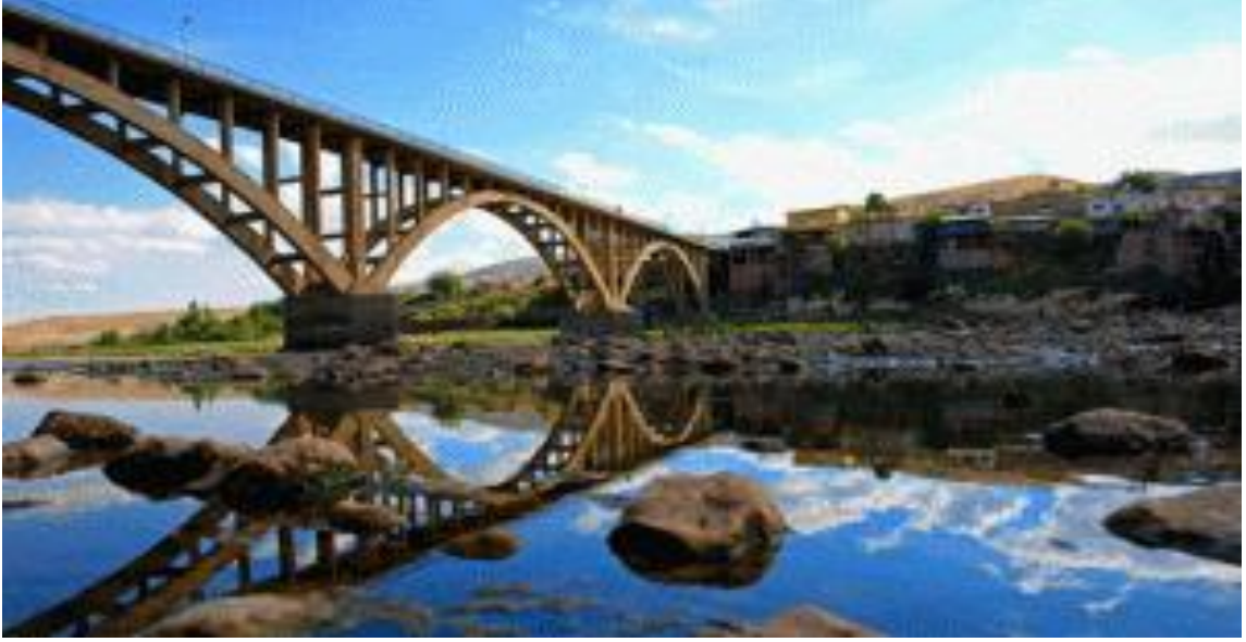
Fotoğraf 2.19. On Kemerli DDY Köprüsü
