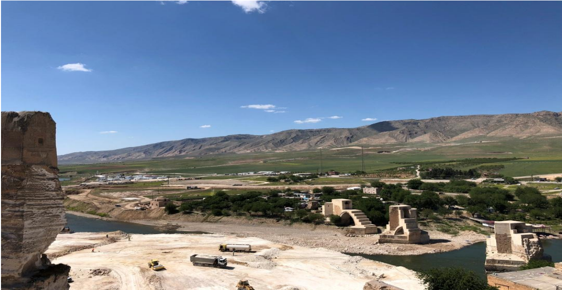
Fotoğraf 2.12. Ilısu Barajı restorasyon çalışmaları
