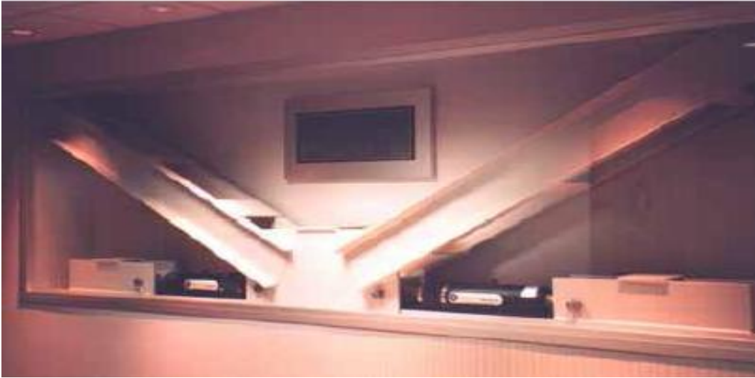
Resim 4.1. Kurulumu tamamlanmış viskoz sönümleyici [1]
