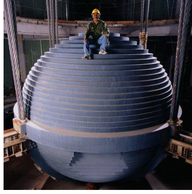
Resim 4.5. Taipei 101 binası kütle-yay sistemi, Tayvan [35]
