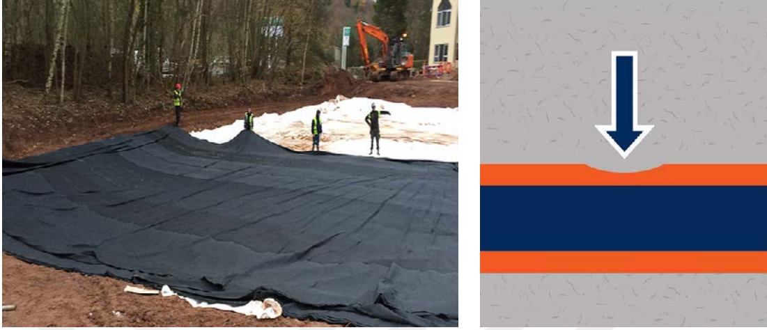
Resim 2.3. Jeotekstilin stabilizasyona ve düzgün yük dağılımına katkısı [37] Resim 2.4. Koruma fonksiyonu [38]
