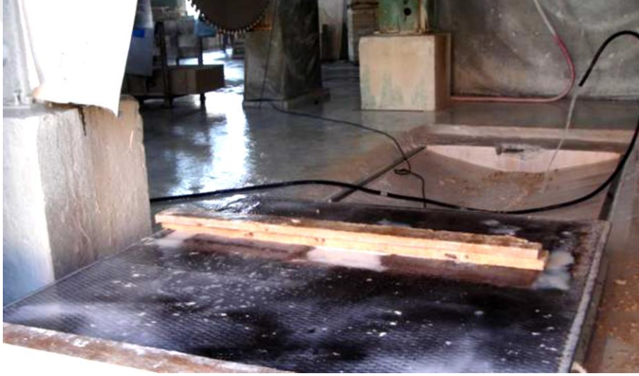
Resim 3. 17. ST Makinesi blok taşıma vagonuna ahşap takozların yerleştirilmesi [Anonim 3 , 2011].
