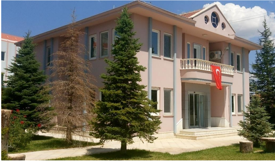
Resim 3. 52. Mermer işleme tesisi idare binası
