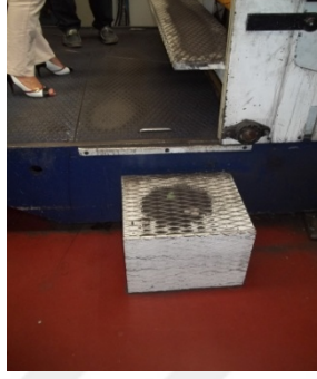
Resim 5.14. Cpt Kablo Kanalı
