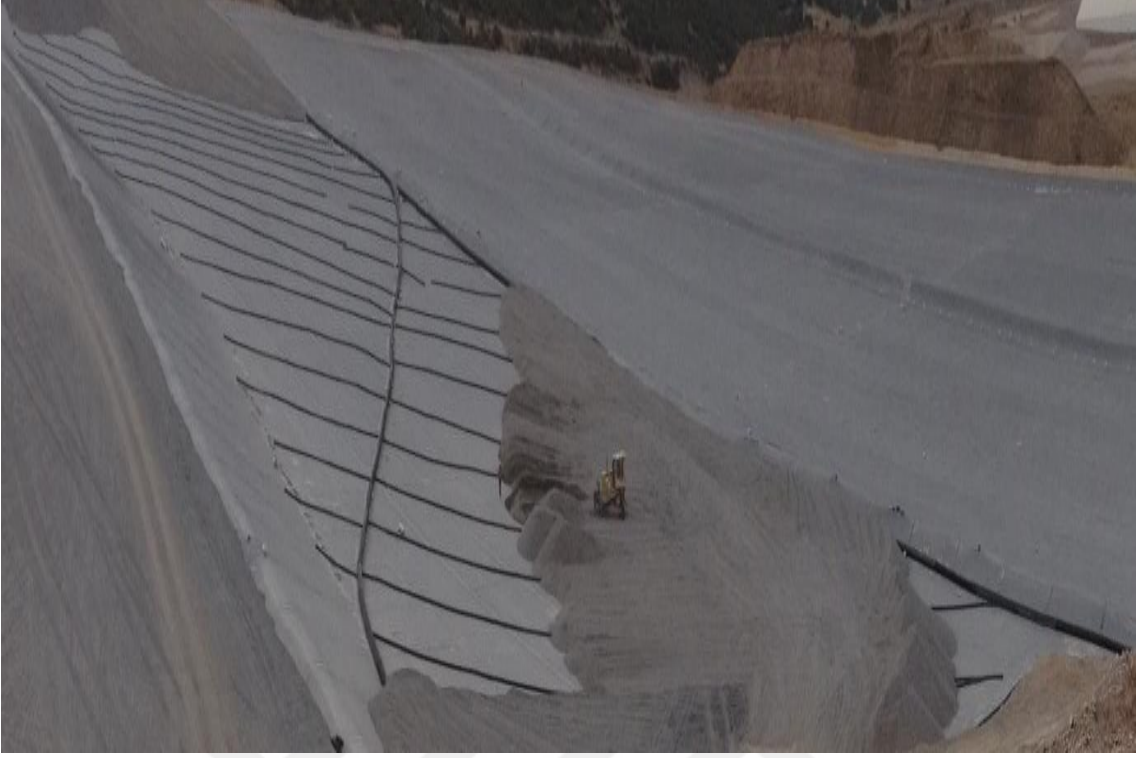
Resim 3.2 Yığın liçitoplama freatikseviye dolgusu
