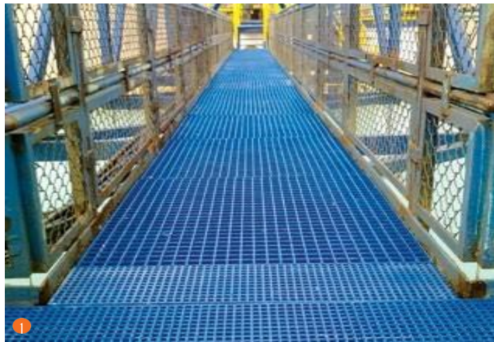
Şekil 1.8. Profil çekme yöntemi ile cam lifinden üretilmiş ızgaralar [18]
