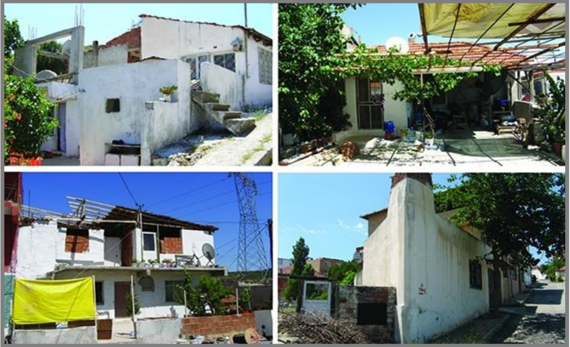
Resim 4.8. Uzundere Kentsel Dönüşüm Alanı yıkım çalışmaları [99]
