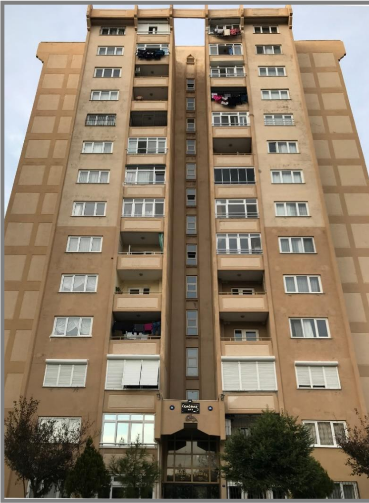
Resim 5.10. Uzundere TOKİ Çağdaş Apartmanı (02.12.2017)
