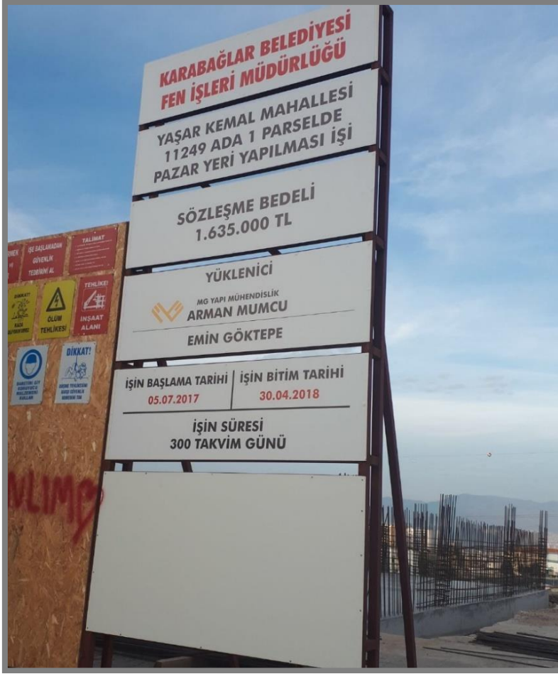
Resim 5.16. Uzundere TOKİ pazar alanı inşaatı (02.12.2017)
