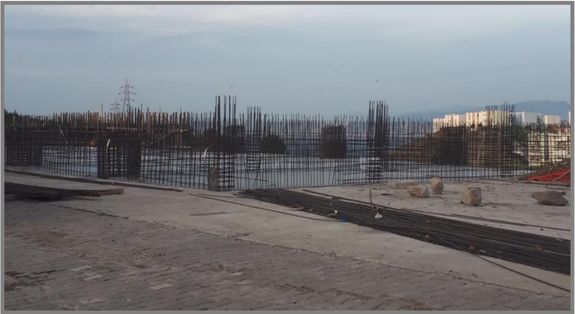
Resim 5.19. Uzundere TOKİ pazar alanı inşaatı (02.12.2017)
