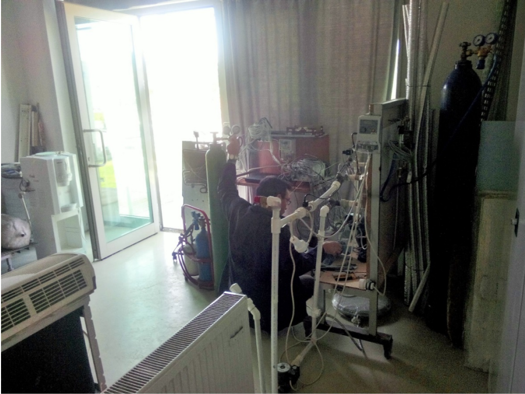
Resim 3. 1. Mahal ısıtma amaçlı olarak tasarlanan su kaynaklı ısı pompasının genel görünüşü
