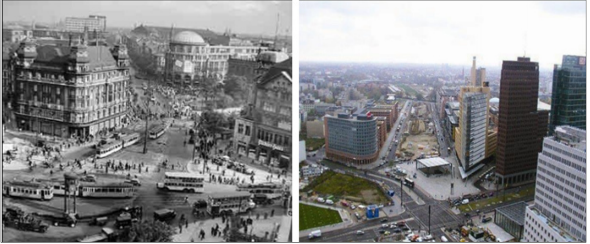
Resim 2.5. Potsdam Meydanı kentsel dönüşüm öncesi ve dönüşüm sırasında şantiye alanı [14]
