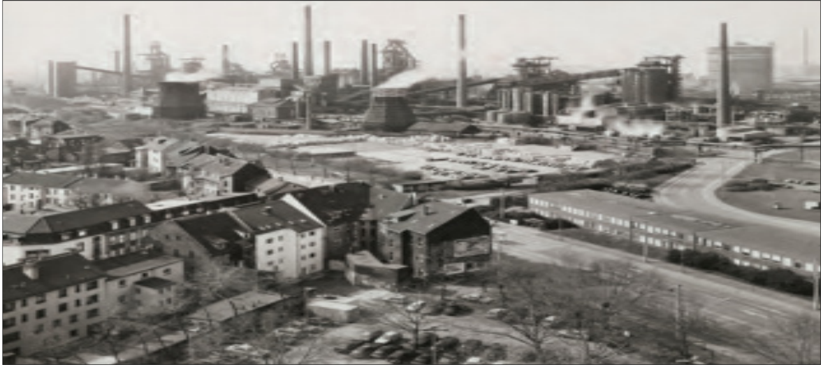
Resim 3.3. Dönüşümden önce Ruhr demir çelik fabrikası (1987) [38]
