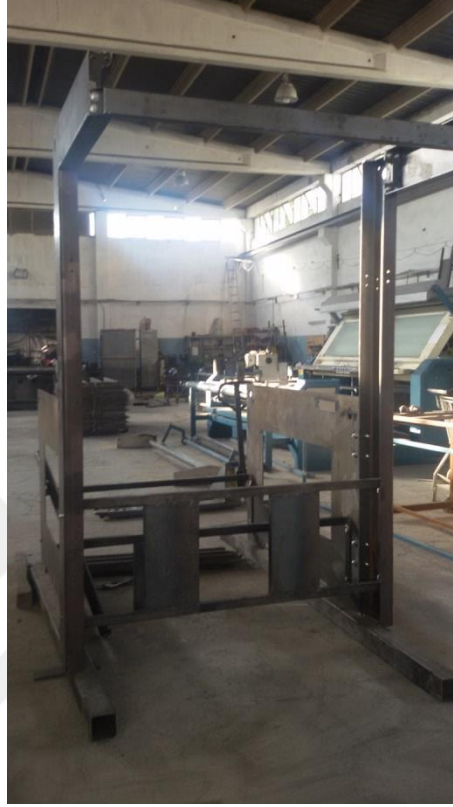
Resim 6.3. Giriş kısmın karkas montaj görünümü
