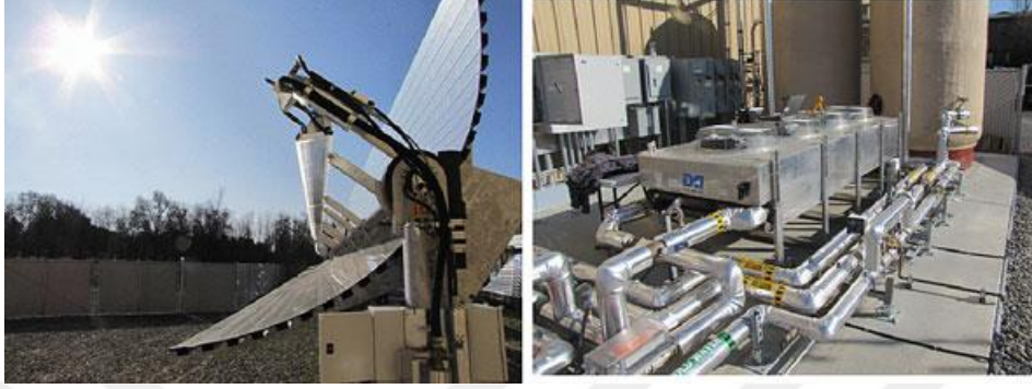
Resim 2.2 Parabolik Oluklu PVT Sistem [9]
