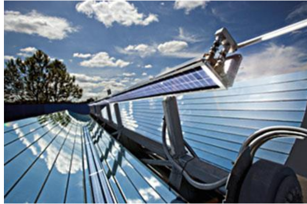
Resim 2.3 Bütünleşik PVT üçgen alıcı detayı [10]
