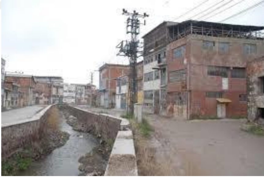
Resim 5.9.1. Tabakhane bölgesinde dönüşüm öncesi bulunan yapı örneği
