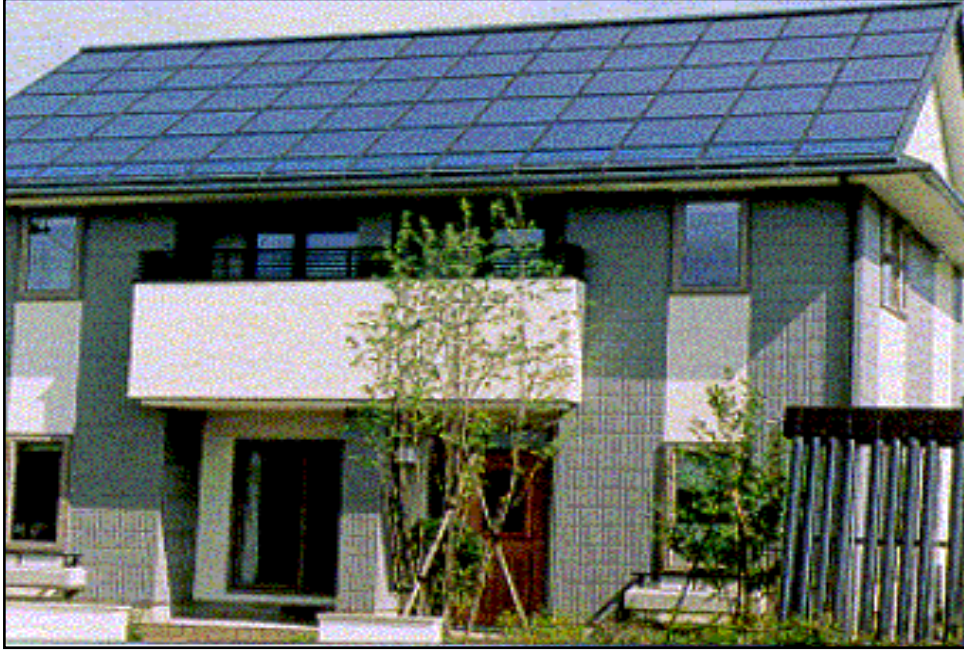
Şekil 1.20. Çatısı güneş pili kaplı ev
