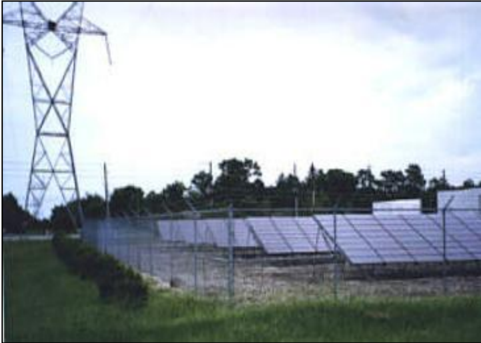
Şekil 1.21. Şebekeye elektrik veren güneş pili sistemi
