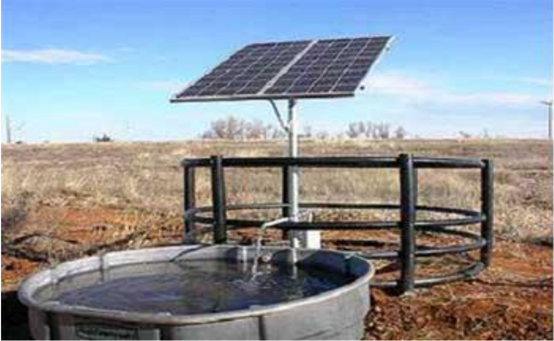
Şekil 1.30. Güneş pillerinin su pompalama sisteminde kullanımı (URL-13, 2011).
