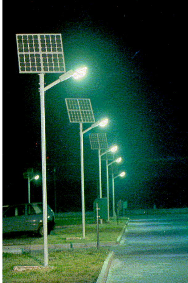
Şekil 1.26. Güneş pillerinin sokak aydınlatmasında kullanımı (URL-13, 2011).
