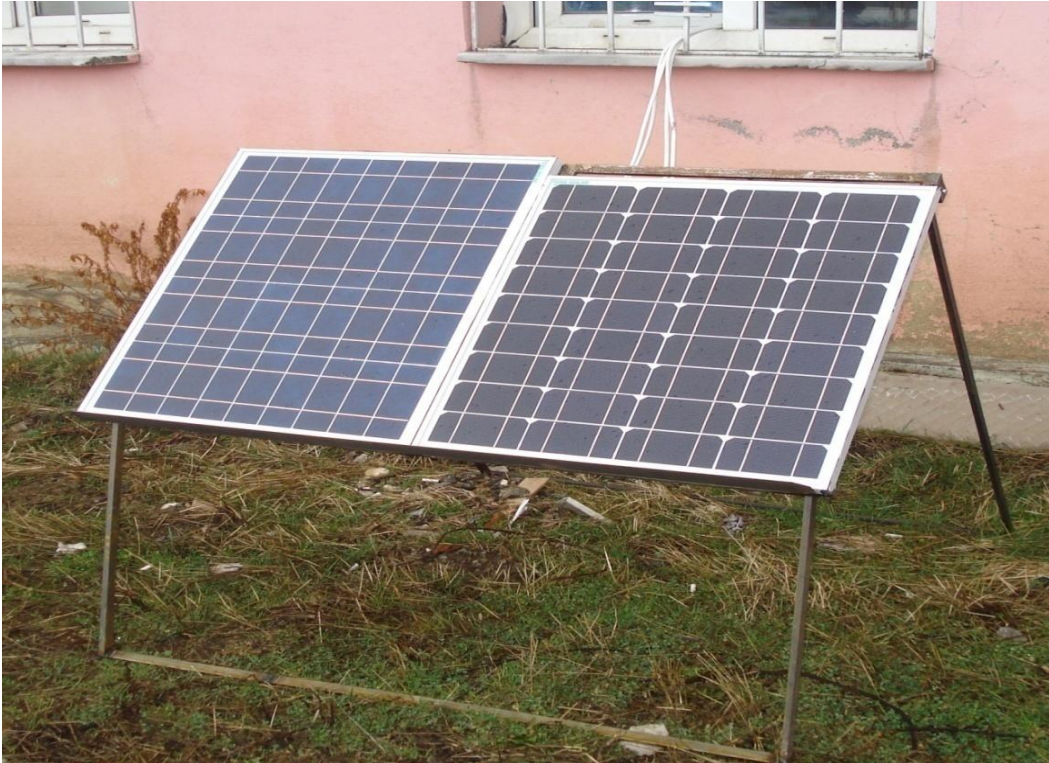
Şekil 2.7. Monokristal ve polikristal güneş modüllerinin konumlandırılması
