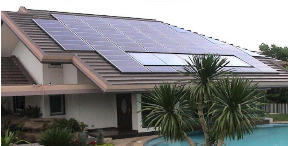
Şekil 1.32. Çatısı güneş pilleriyle kaplı artı enerjili bir bina(URL-13, 2011).
