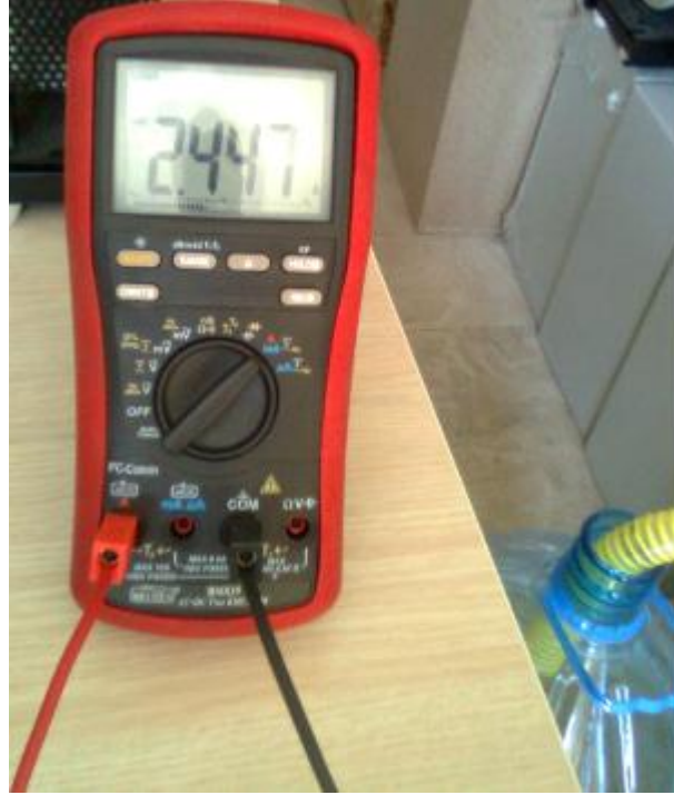
Şekil 7.5. Akü grubu şarj oldukça PV'den çekilen akım düşmüştür
