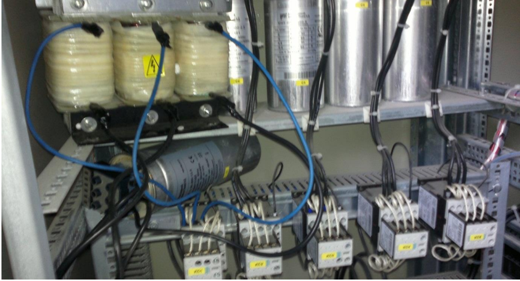
Şekil 7.13. Harmonik filtre reaktörün kompanzasyon sistemine bağlantısı
