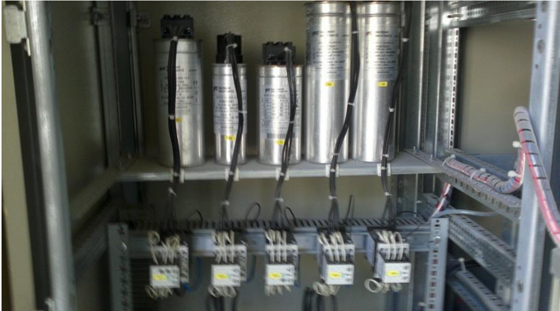
Şekil 7.9. Sistemin kompanzasyon panosu
