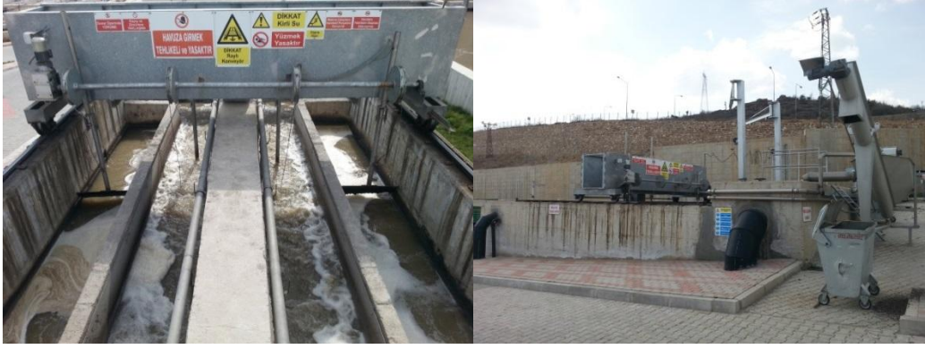
Şekil 4.5. Havalandırmalı kum ve yağ tutucuları
