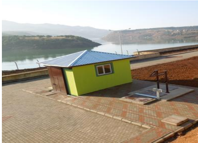
Şekil 4.11. Süzüntü suyu pompa ünitesi
