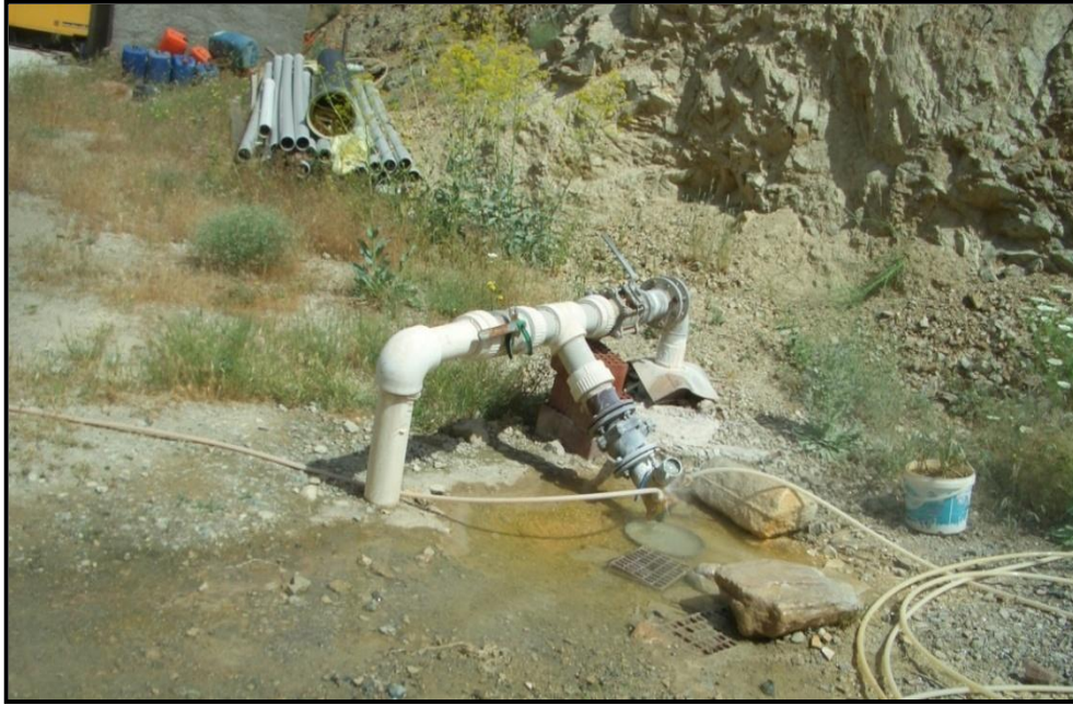
Şekil 3.14. Singeç Vadisi güneyinde bulunan ve Pertek termal otele suyu verilen sıcak su sondajı (S-1)
