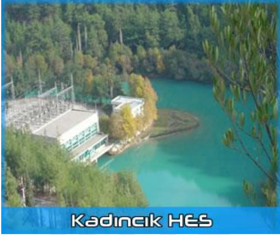
Şekil 1.2 Kadıncık 1 Hidroelektrik Santrali.
