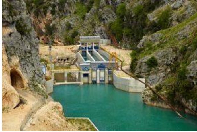
Şekil 1.4 Lamas 3 ve 4 Hidroelektrik Santrali.
