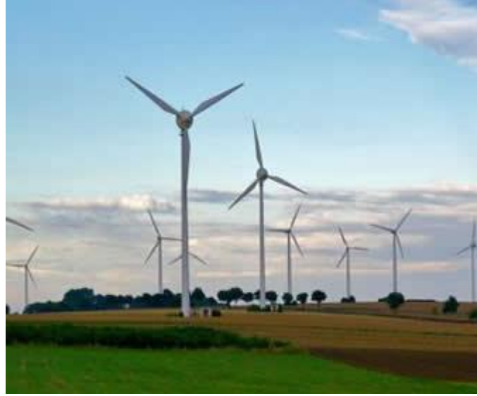
Şekil 2.3 Mersin Rüzgar Enerji Santrali
