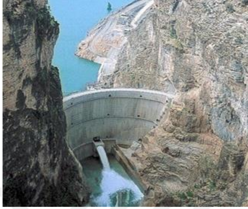
Şekil 1.1 Gezende Hidroelektrik Santrali.
