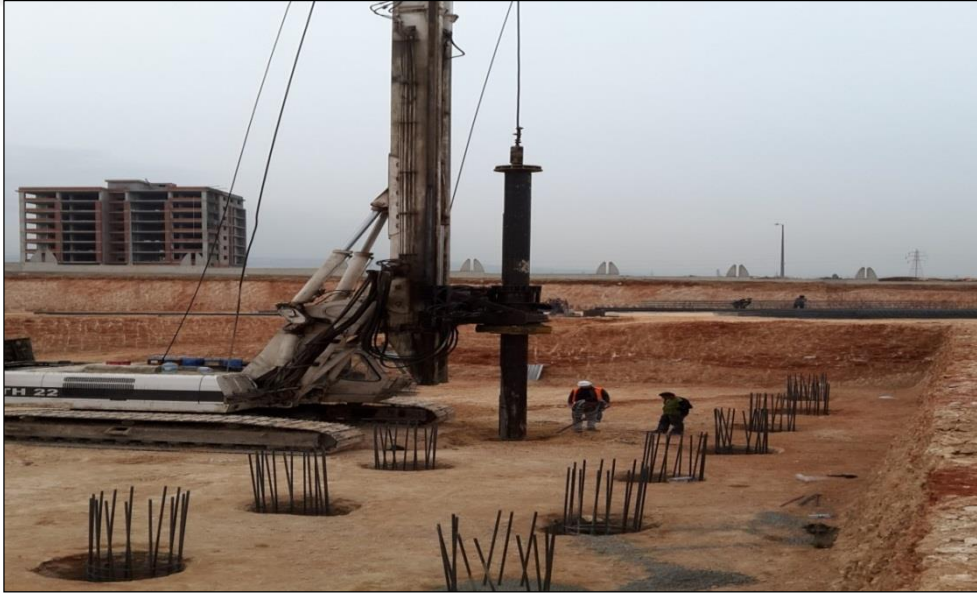
Şekil 2.5 Seçilen 33 katlı binanın fore kazık saha çalışmasından görünümü.
