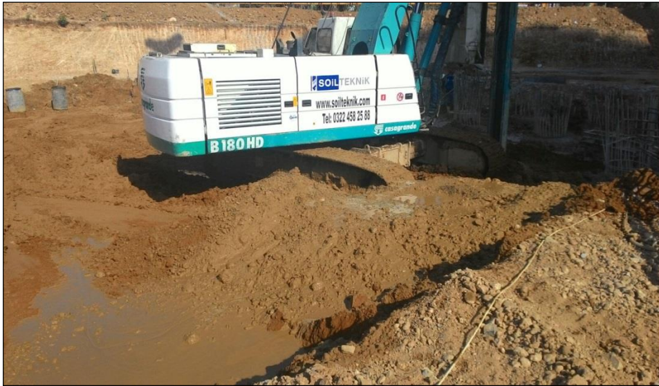
Şekil 2.3 Seçilen 28 katlı binanın fore kazık saha çalışmasından görünümü.
