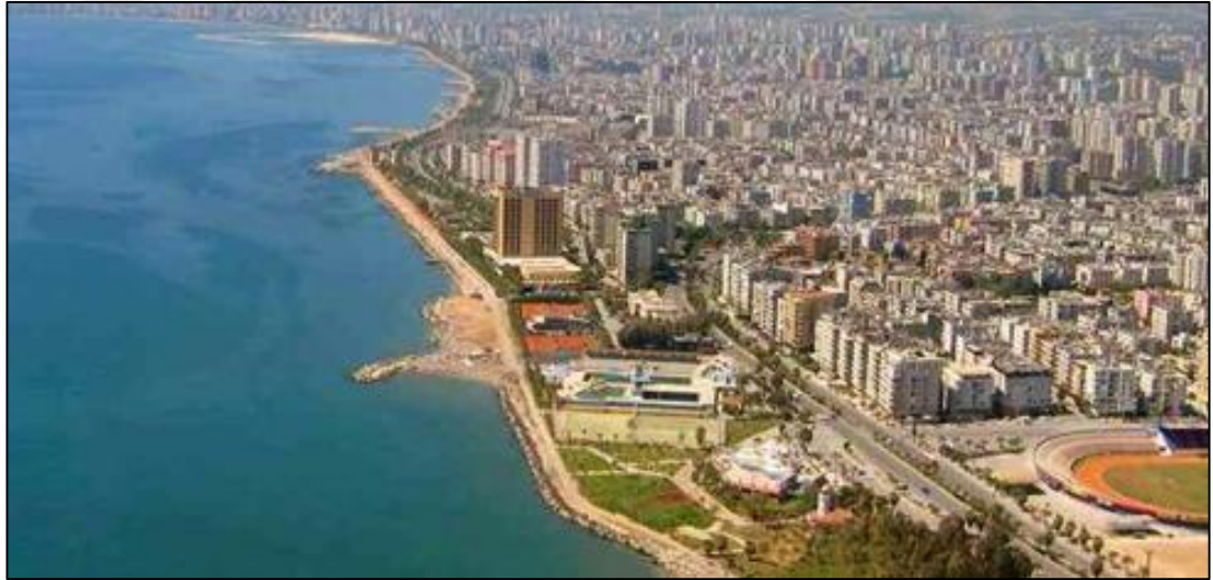
Şekil 1.4 İnceleme alanının genel görünümü
