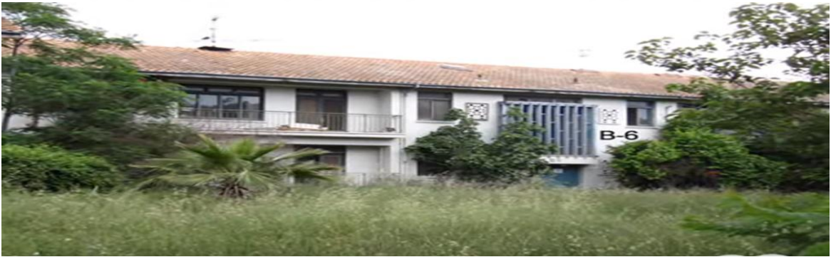
Şekil 3.26. Ataş Yerleşkesi B tipi konutlar – B 6 blok (Süleyman Vurandemir arşivinden)
