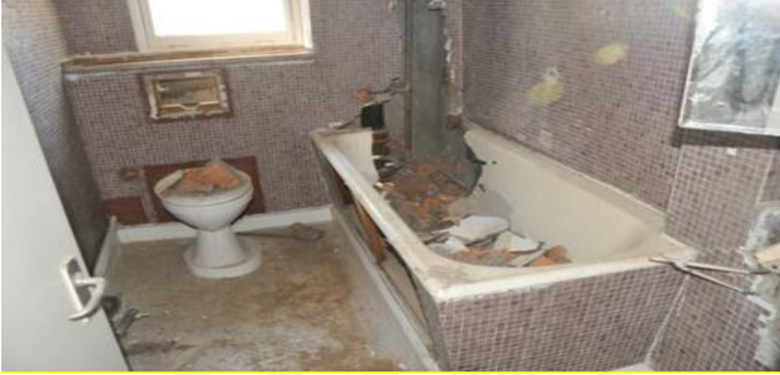
Şekil 2.25. Ataş lojman alanı banyo görünümü (Akdeniz Belediye arşivinden)
