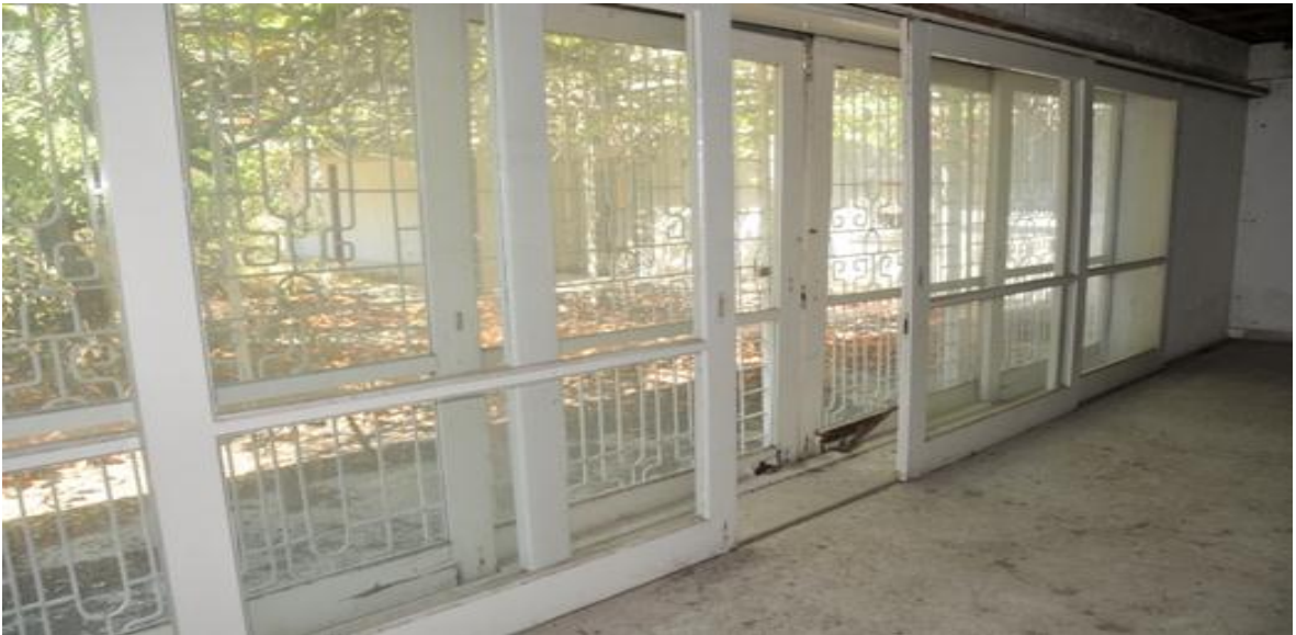
Şekil 2.16. Ataş lojmanları sürme-akordeon tipi çift kayıt sistemli pencere kapı detayı (Akdeniz Belediye arşivinden)
