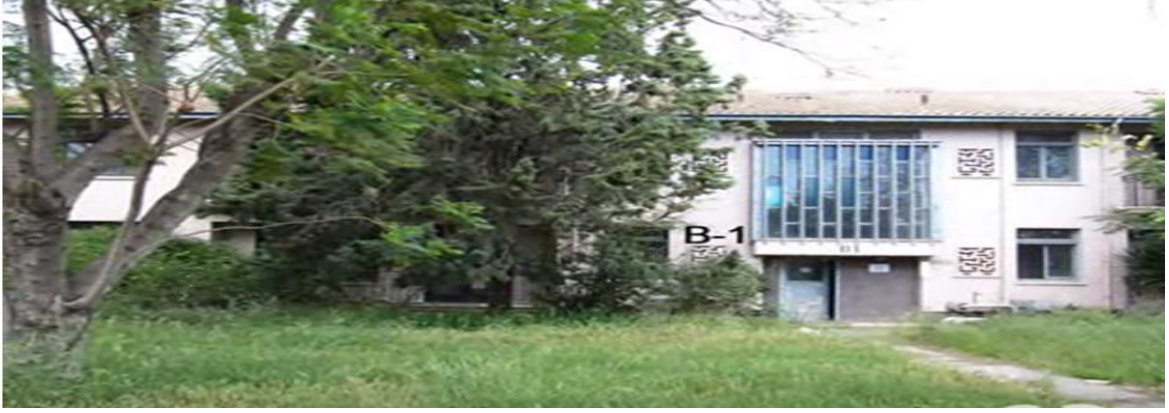
Şekil 3.21. Ataş Yerleşkesi B tipi konutlar – B 1 blok (Süleyman Vurandemir arşivinden)
