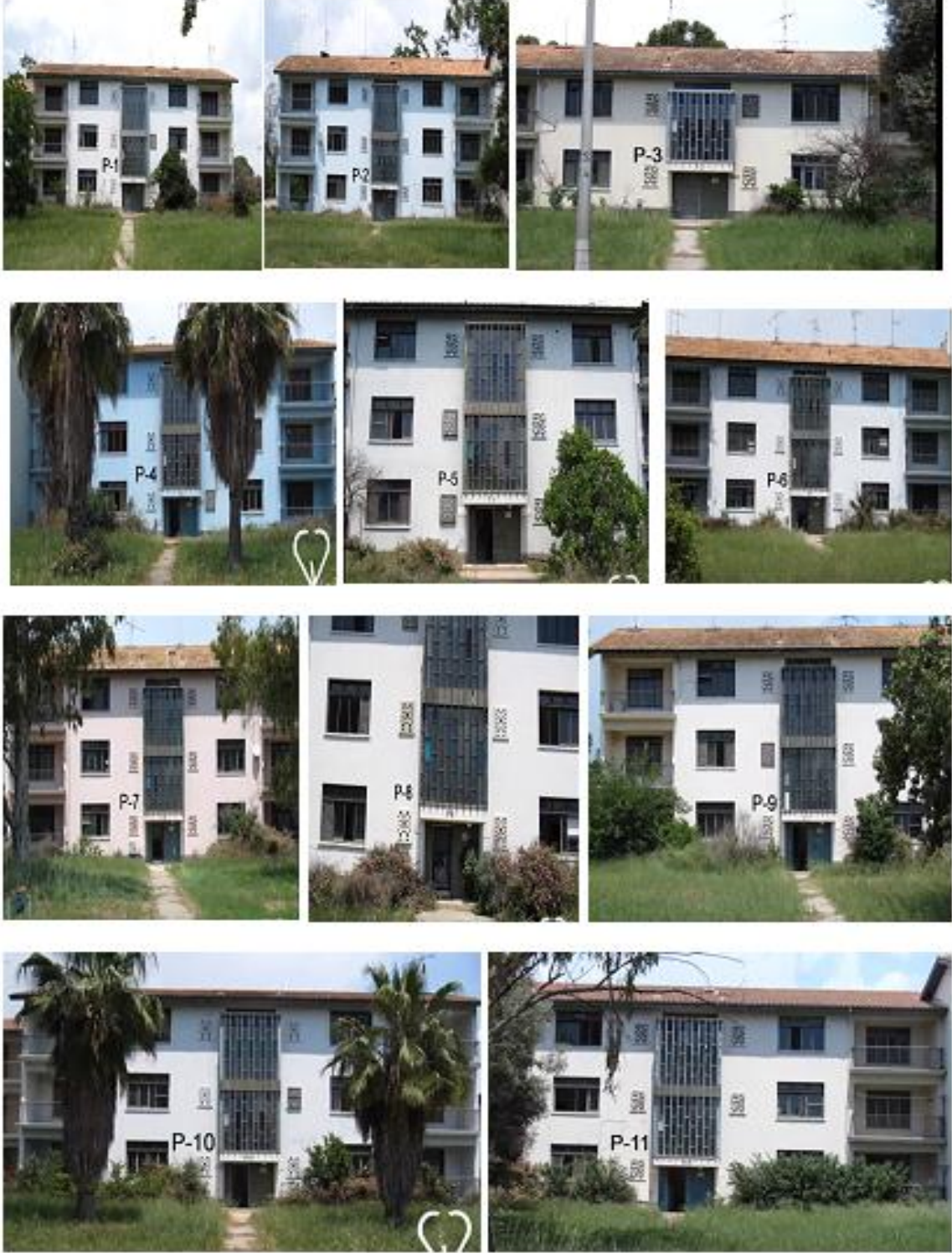
Şekil 3.37. Ataş Yerleşkesi P tipi konutlar – P 1 / P 2 /P 3 /P 4 /P 5 /P 6 /P 7 /P 8 /P 9 /P 10 /P 11 blok (Süleyman Vurandemir arşivinden)
