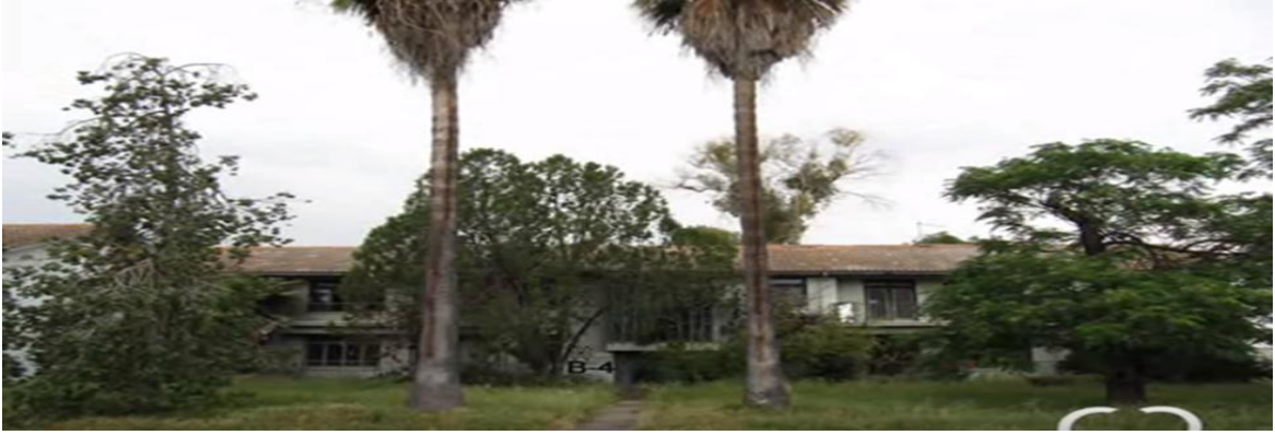
Şekil 3.24. Ataş Yerleşkesi B tipi konutlar – B 4 blok (Süleyman Vurandemir arşivinden)
