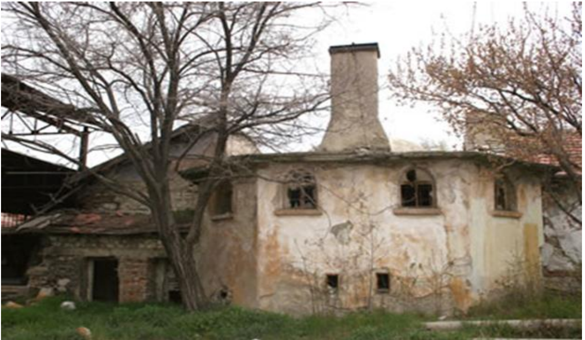
Şekil 2.43. Hasanoğlan Köy Enstitüsü günümüze ulaşan yapılar-fırın (Çakıcı ve Çorakbaş, 2013: 4)
