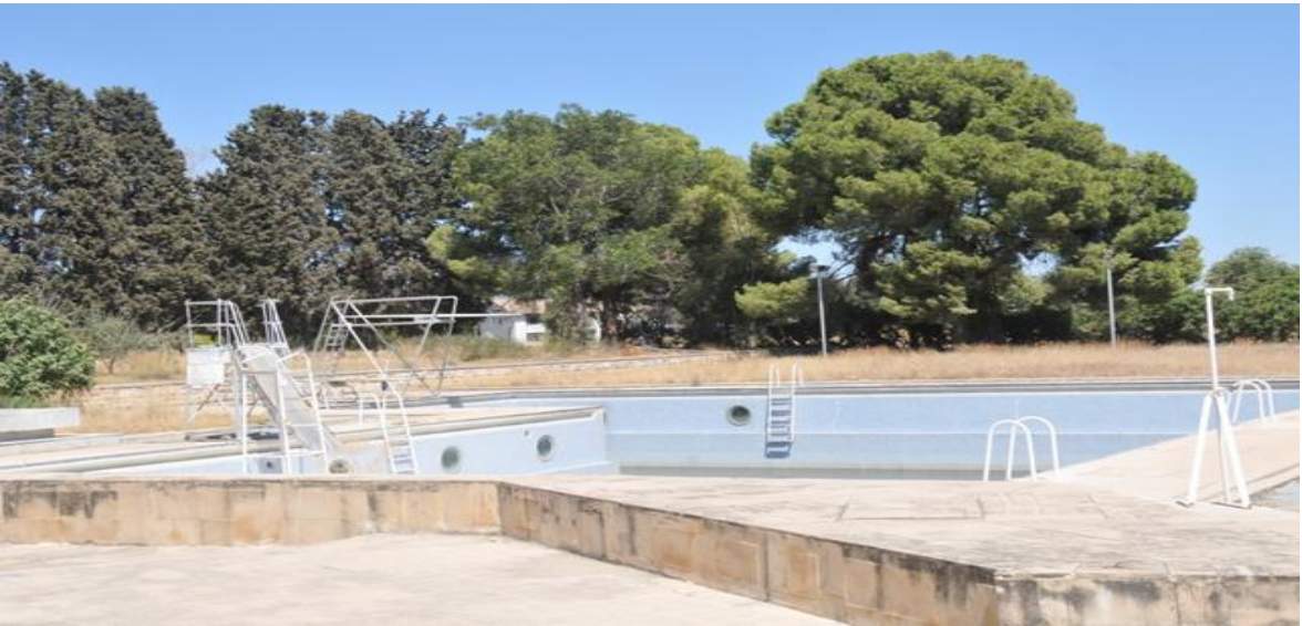
Şekil 2.19. Ataş lojmanları olimpik yüzme havuzu (Akdeniz Belediye arşivinden)
