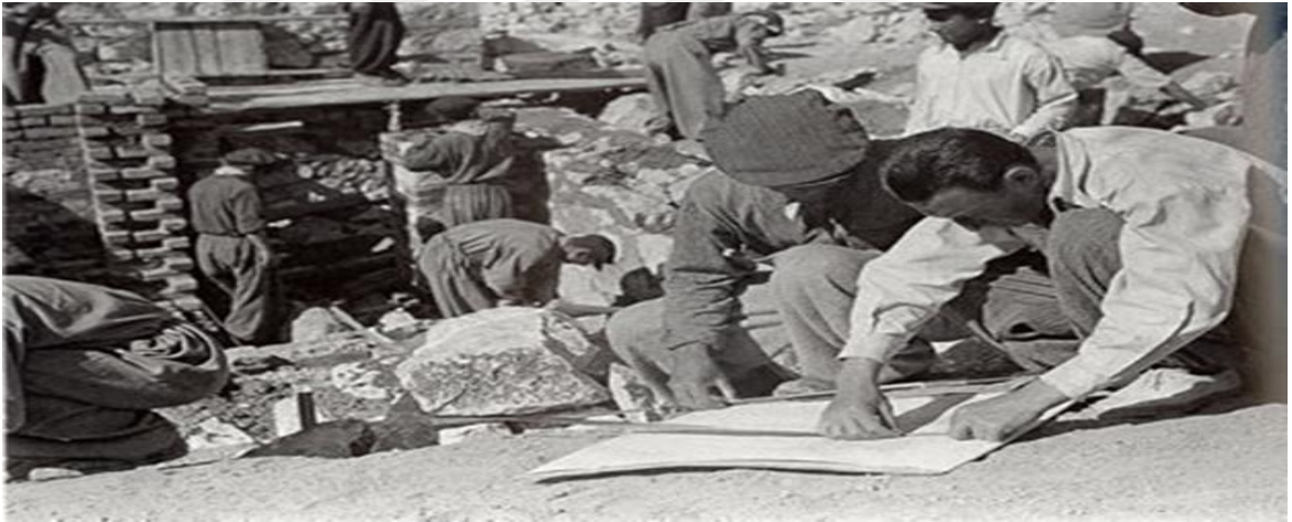
Şekil 2.41. Hasanoğlan Köy Enstitüsü inşa çalışmaları (Çakıcı ve Çorakbaş, 2013: 2).
