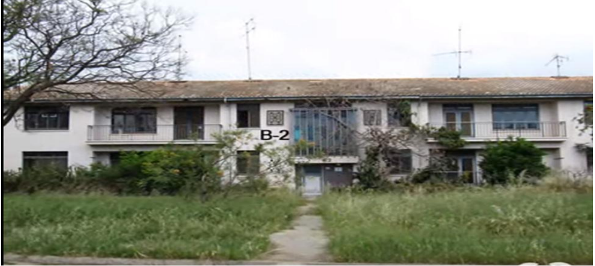
Şekil 3.22. Ataş Yerleşkesi B tipi konutlar – B 2 blok (Süleyman Vurandemir arşivinden)
