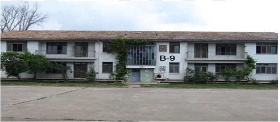
Şekil 3.29. Ataş Yerleşkesi B tipi konutlar – B 9 blok (Süleyman Vurandemir arşivinden)
