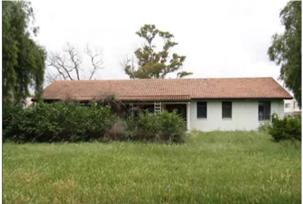
Şekil 3.9. AA tipi konutun dıştan görünümü (Süleyman Vurandemir arşivinden)
