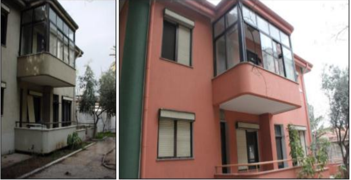
Şekil 2.29. İzmir Sümerbank Basma Sanayi Yerleşkesi müdür evi eski ve yeni görünümü (Uğursal, 2011: 124).
