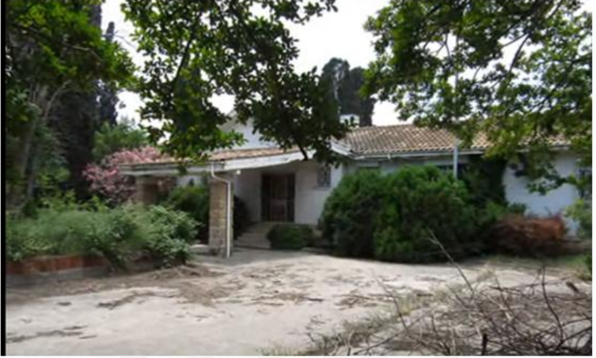
Şekil 3.8. AA tipi konutun dıştan görünümü (Süleyman Vurandemir arşivinden)
