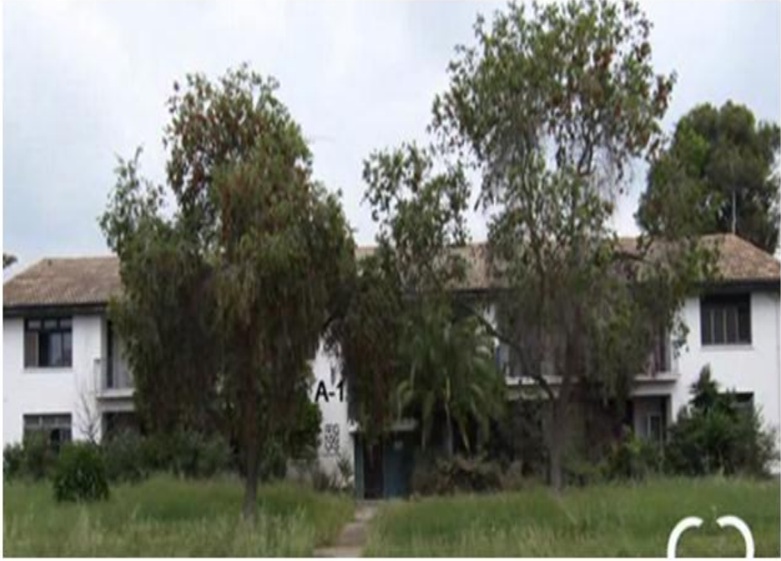
Şekil 3.4. A tipi konutlardan A-1'in dıştan görünümü (Süleyman Vurandemir arşivinden)
