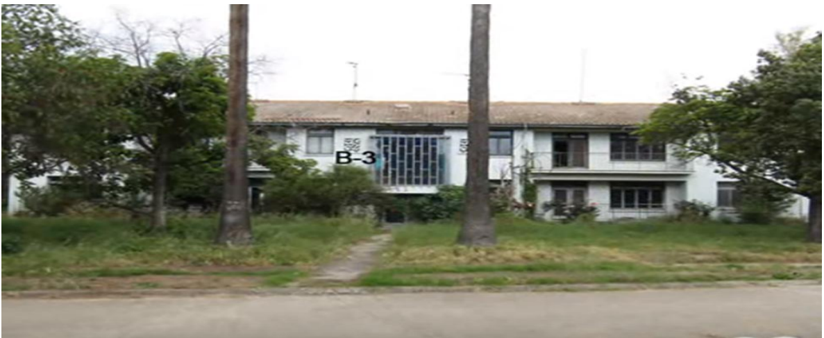
Şekil 3.23. Ataş Yerleşkesi B tipi konutlar – B 3 blok (Süleyman Vurandemir arşivinden)
