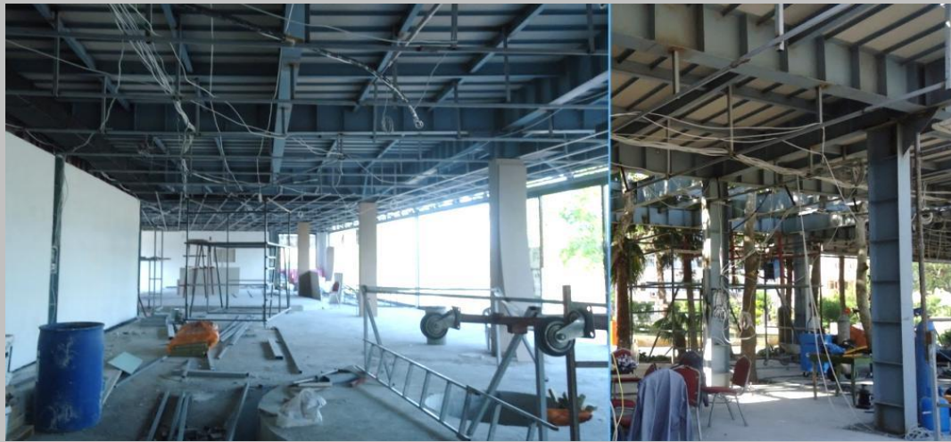
Resim 3.28: Mersin’de ‘çelik yapı tekniği’ ile bir yapı 12
