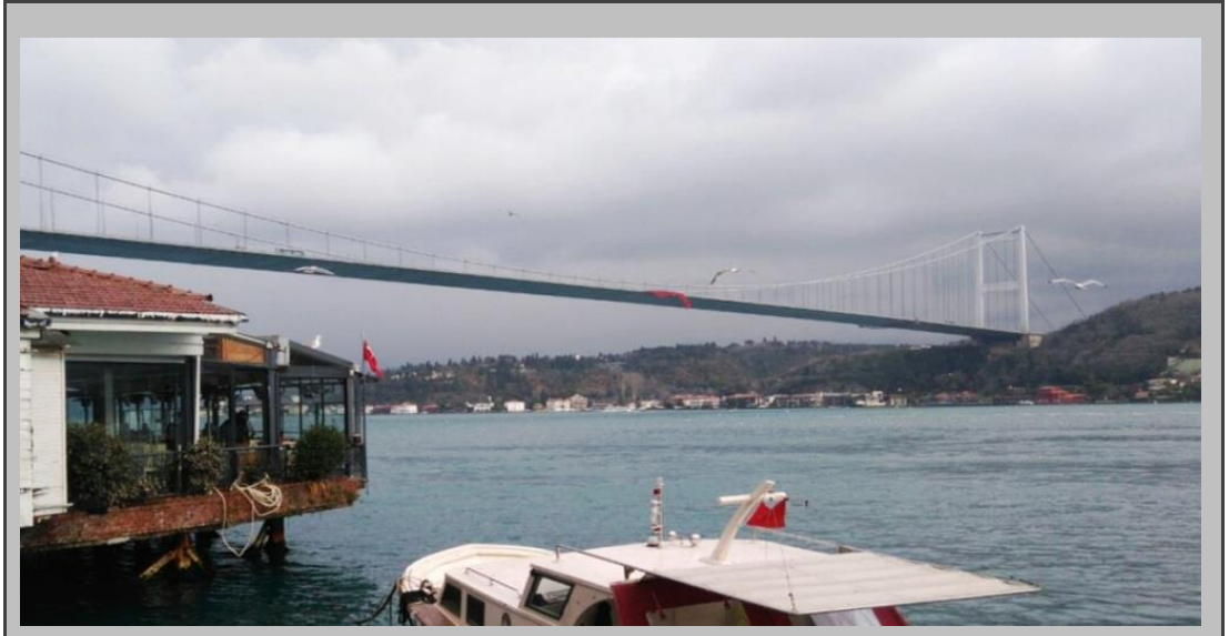
Resim 3.27: Demir esaslı çelik yapıya bir örnek (FSM köprüsü) 11
