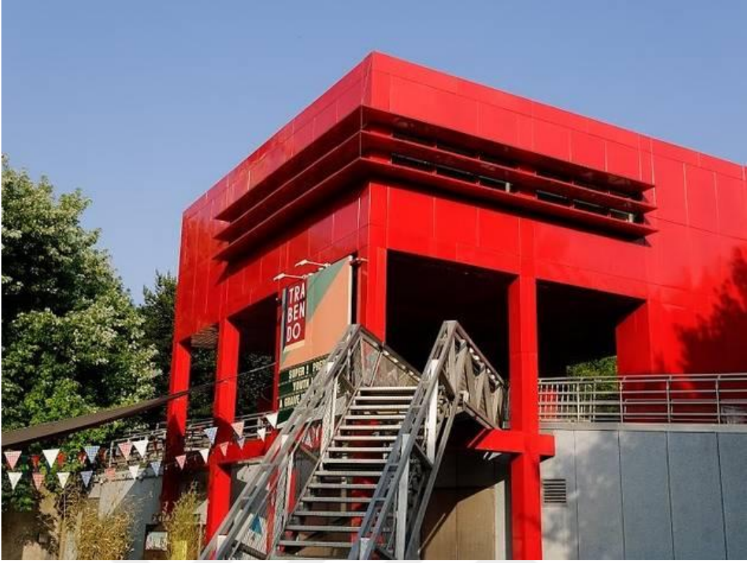
Şekil 1.20. Parc de la Villette 'trebendo' : Trabendo R7 (Performans Salonu)
