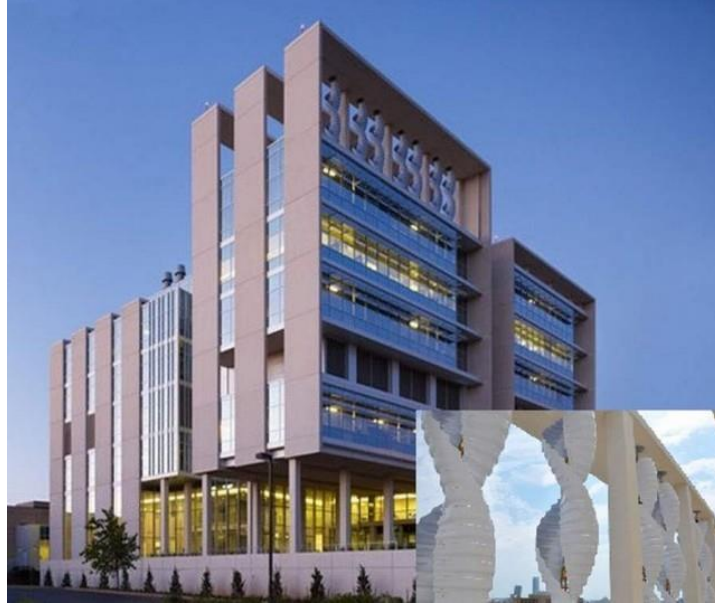
Şekil 2.36. Oklahoma Medical Research Foundation (Mimari Proje: Skidmore Owings& Merrill) çatıda rüzgar türbini uygulaması [22].
