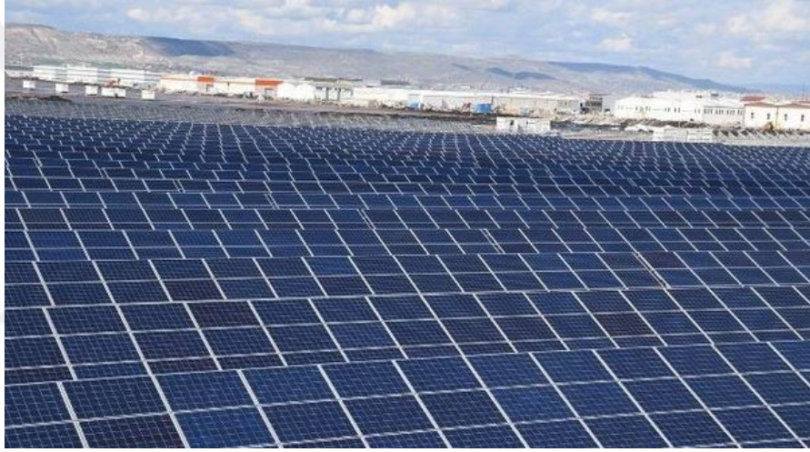
Şekil 2.19. Kayseri Organize Sanayi Bölgesi'nde yapılan fotovoltaik (PV) santrali, Türkiye'nin en büyük güneş enerjisi santrali olacaktır [12].
