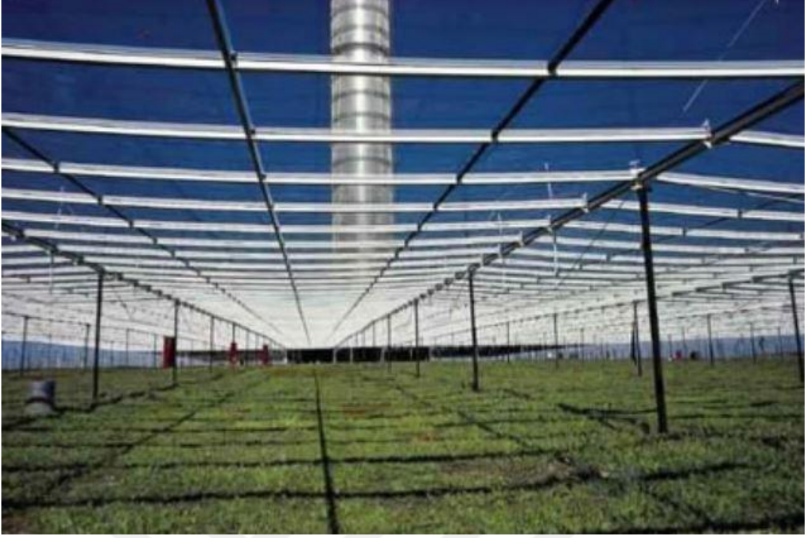
Şekil 2.22. Mildura güneş bacası [14]
