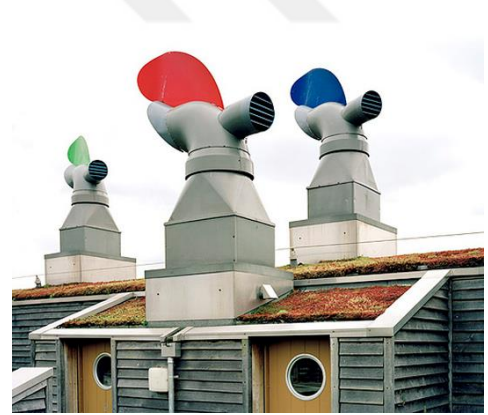
Şekil 3.10. Rüzgar bacası [46]
