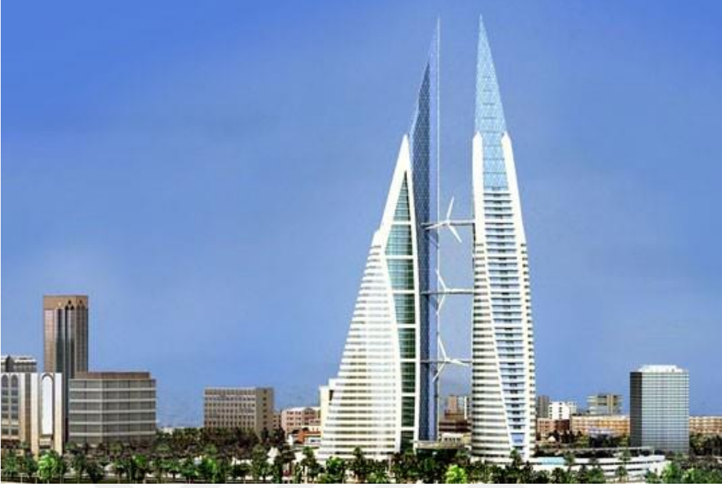
Şekil 2.34. Bahreyn Dünya Ticaret Merkezi (Mimari Proje: Atkins Grubu) iki gökdeleni birbirine bağlayan rüzgar türbinleri vardır. Rüzgar gücüyle ilk elektrik üreten yüksek yapıdır [21].
