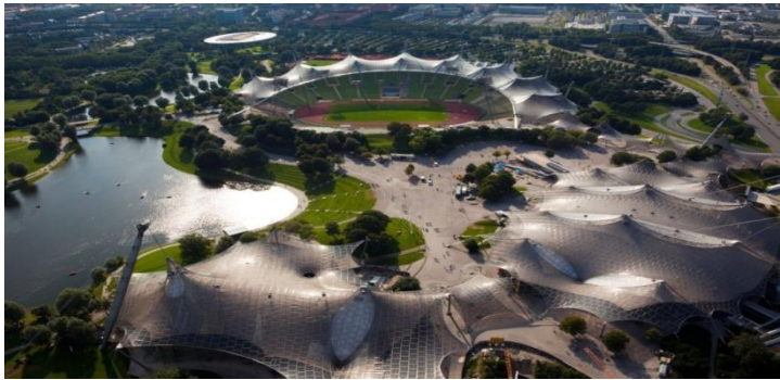
Şekil 1. 16 .Frei otto Münih olimpiyat stadi (Eğrilikleri ters yönde çift eğrilikli strüktür) (URL-16).
