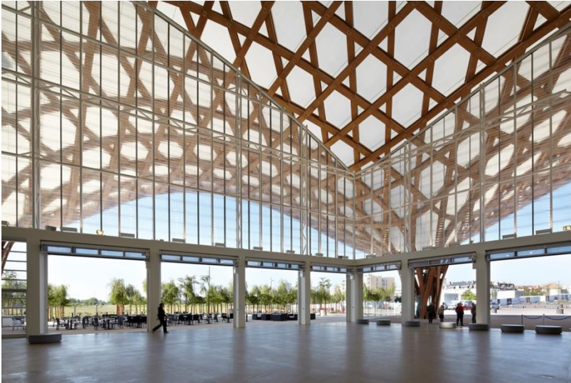
Şekil 2.6. Centre Pompidou-Metz / Shigeru Ban Architects 2010 Fransa Mekân iç görünümü (URL-39).
