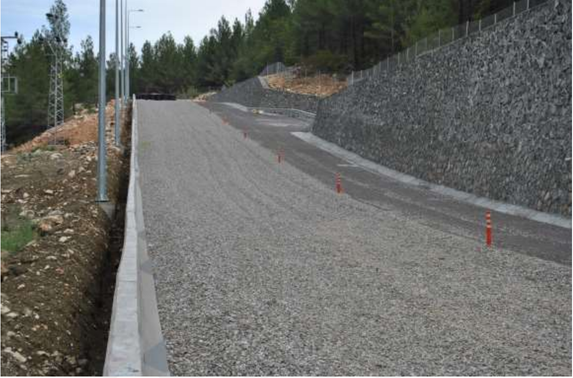
Resim 1.8. Tarsus-Pozantı otoyolu kaçış rampası içerisindeki agrega havuzu
