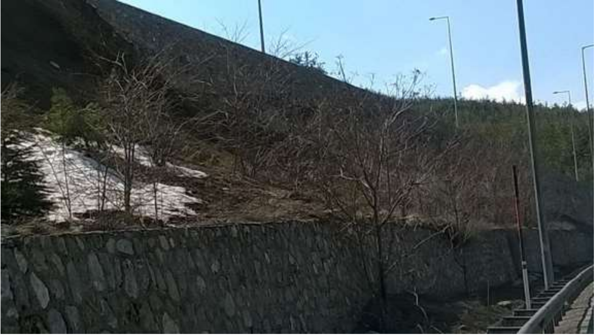
Resim 1.9. Pozantı-Tarsus otoyolu üzerindeki kaçış rampası istinat duvarı
