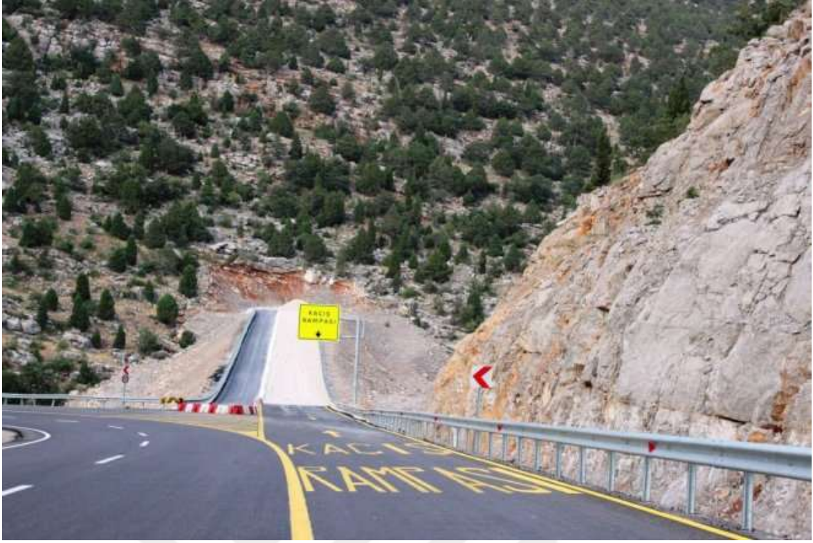
Resim 1.4. Seydişehir-Antalya otoyolu üzerindeki kaçış rampası [3]
