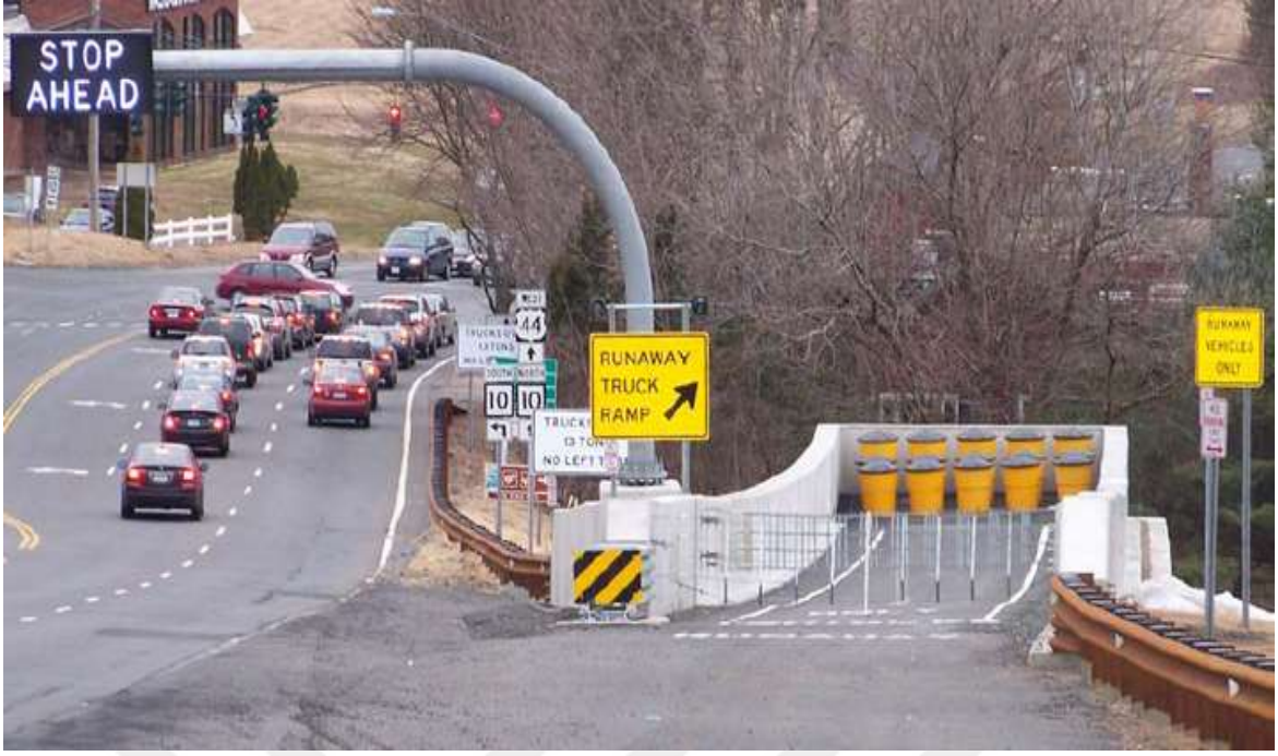
Resim 2.2. Avon, Connecticut’da US 44 otoyolunun batı kıyısında bulunan ağ yakalayıcı sistem (Hanley, 2007).
