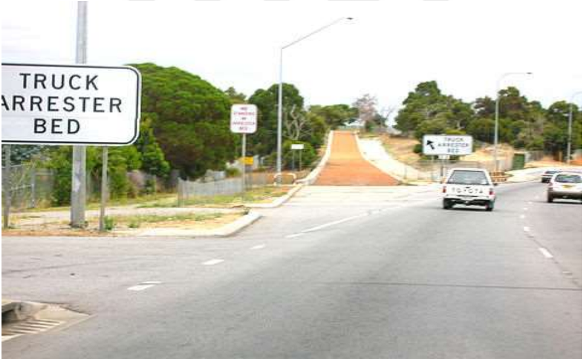
Resim 1.5. Avustralya'da Great Eastern otoyolu üzerindeki kaçış rampası [4]
