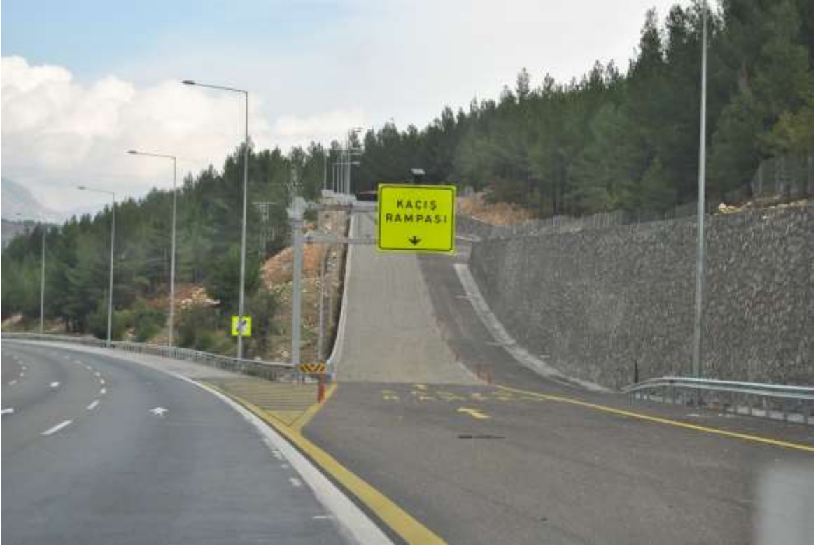
Resim 1.11. Yerçekimi prensibiyle çalışan kaçış rampası
