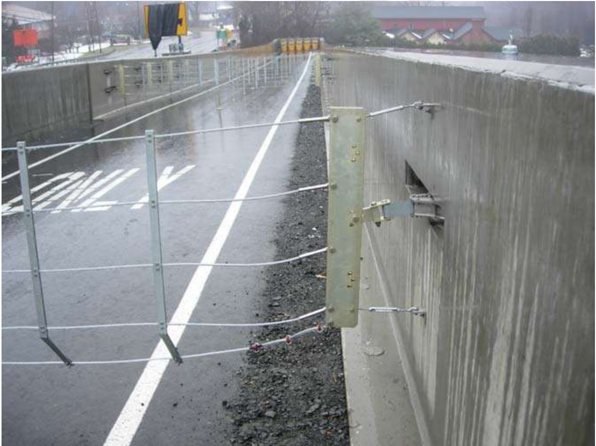
Resim 2.3. Dragnet ağ yakalayıcı sistem (Hanley, 2007)
