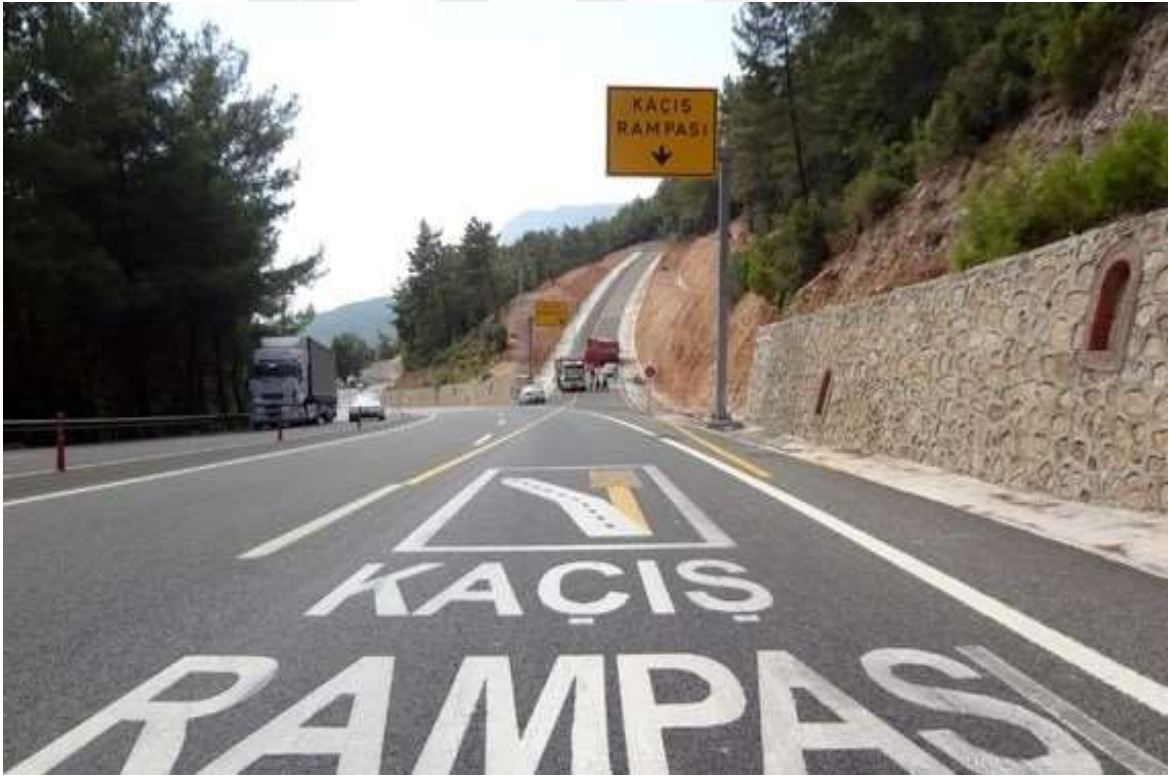
Resim 1.1. Tarsus-Pozantı otoyolu kaçış rampası
