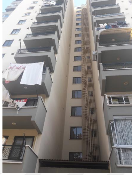
Şekil 3.5.7: Soli4'deki M bloğun yangın merdiveni.
