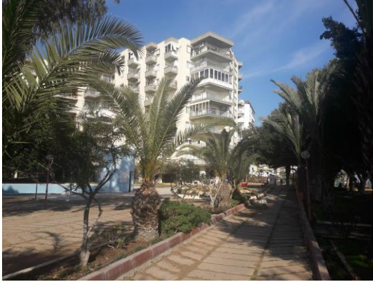
Şekil 3.4.3.1: Soli3'deki J Blok ve havuzu.
