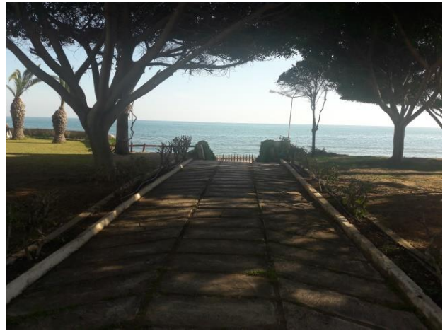
Şekil 3.5.2: Dökme taştan yapılan zemin döşemesi.
