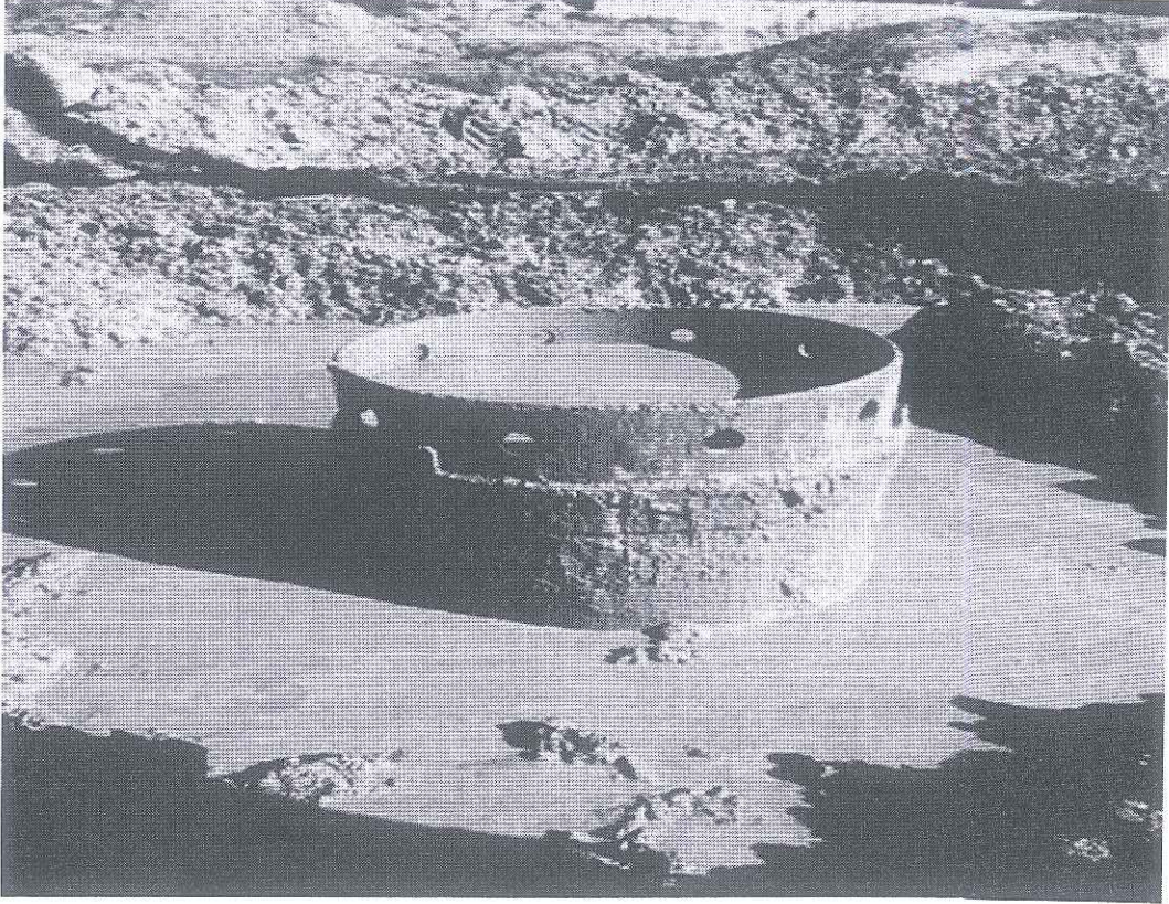
Resim 4.9. Çalışma alanında fore kazık kuyusunun betonlanması
