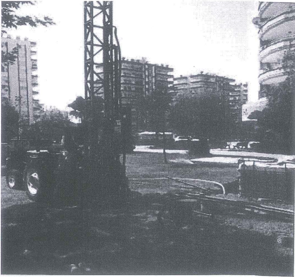
Resim 2.1. İnceleme alanında açılan SK1'e ait sondaj yerinden alınmış fotoğraf
