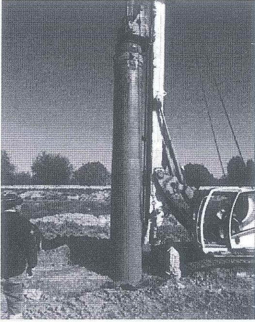
Resim 4.7. Çalışma alanında fore kazık kuyusunun borulanması
