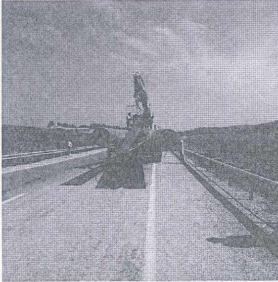
Resim 3.1 Boru nakli (Pamukluk Barajı Sulaması)
