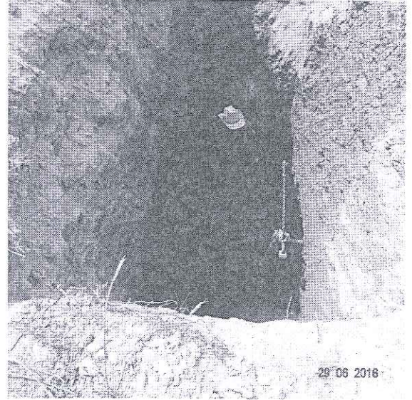
Resim 1.2 Kılavuz delgi genişletilmesi (Pamukluk barajı sulaması)
