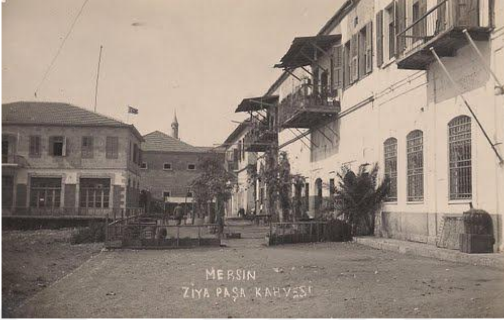
Şekil 4.13. Ziya Paşa Gazinosu(Günümüz PTT binası) (Geylani, 2012, s.109)
