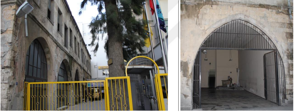
Şekil 4.14. Ziya Paşa Gazinosu restorasyon öncesi (Mersin İl Kültür ve Turizm Müdürlüğü)
