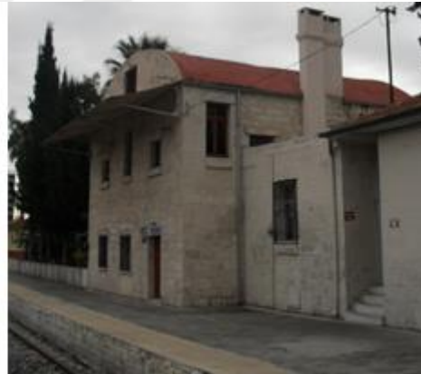
Şekil 4.87. Mersin eski Tren Garı restorasyon sonrası (Kişisel arşiv)
