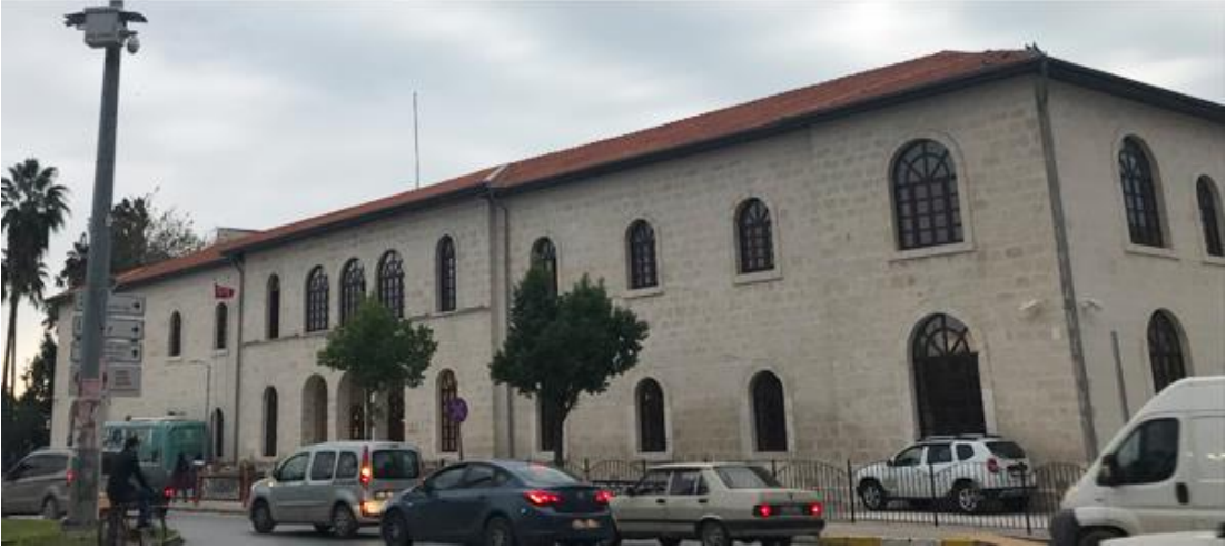
Şekil 4.18. Çocuk Esirgeme Kurumu/İl Halk Kütüphanesi restorasyon öncesi (Mersin İl Kültür ve Turizm Müdürlüğü) ve altta restorasyon sonrası (kişisel arşiv)
