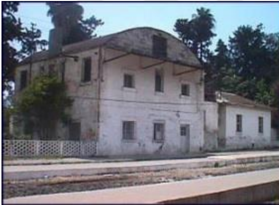
Şekil 4.86. Mersin eski Tren Garı restorasyon öncesi (Şenyiğit ve Erten, 2011)
