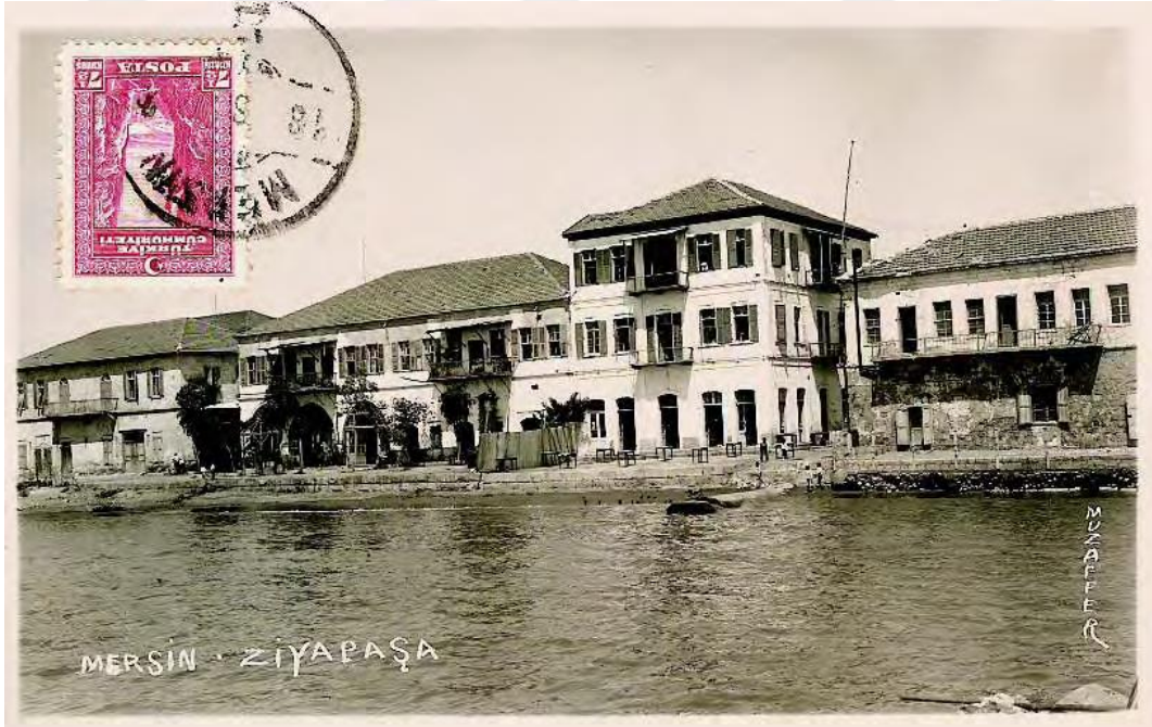
Şekil 4.12. Ziya Paşa Gazinosu (Günümüz PTT binası), Postane, Taş Han (Ünlü ve Ünlü, 2009, s.104)
