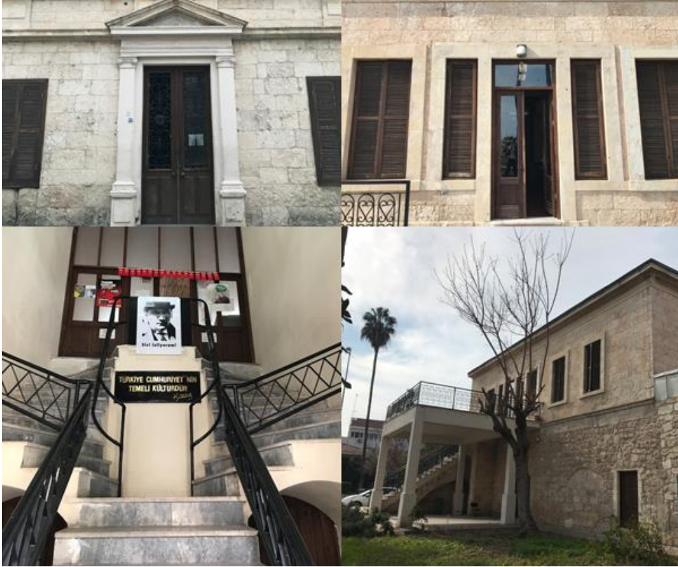
Şekil 4.56. Ziraat Bankası giriş aksı ve teras cephesi (kişisel arşiv)
