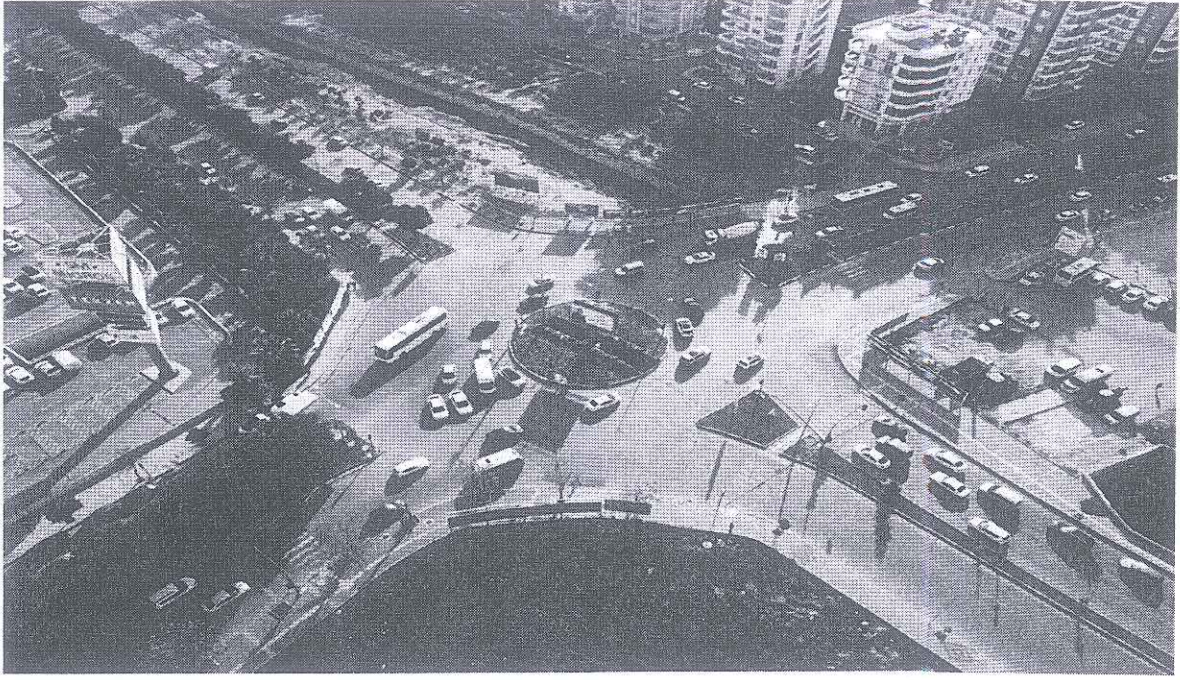
Resim 3.1. Kipa AVM kavşağı - Yenişehir/Mersin
