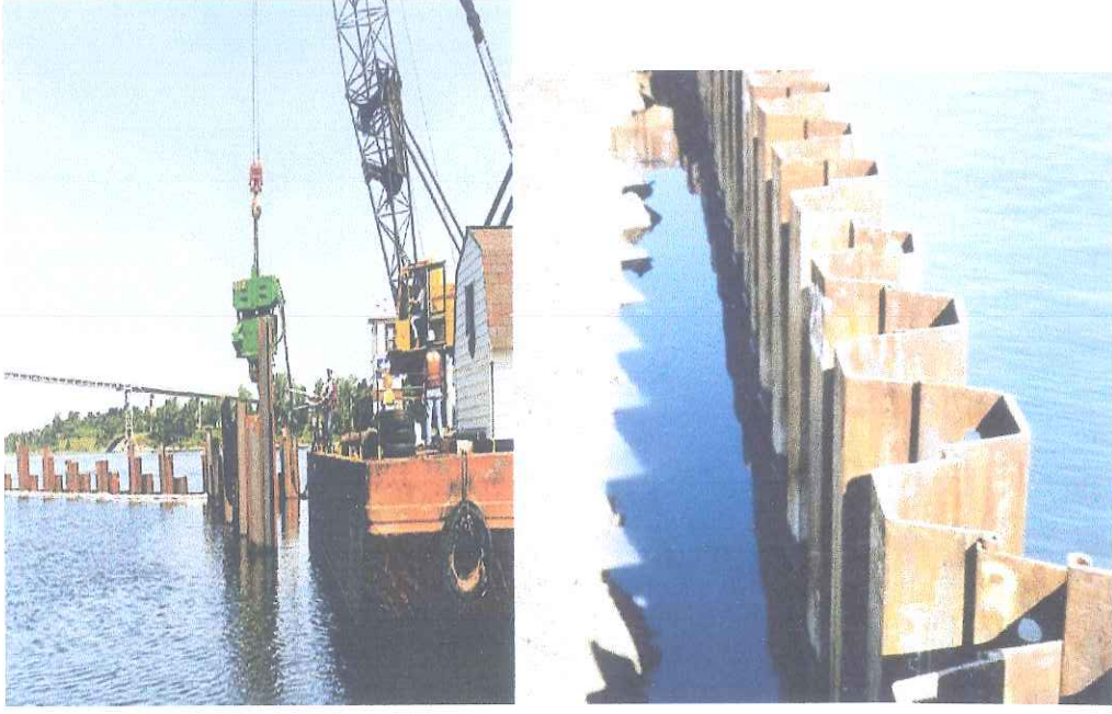
Şekil 3.4. Çelik palplanş perde
