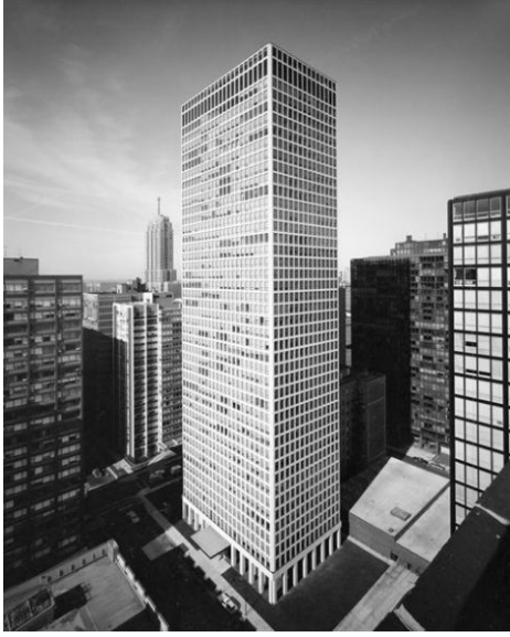
Şekil 2.11. Dewitt-Chesnut Tower, Chicago (1965) Kaynak: (URL 8).
