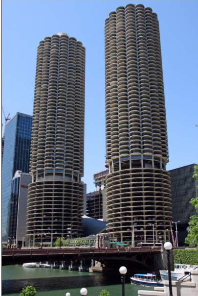
Şekil 3.26. Marina City Towers, Chicago(1964)
