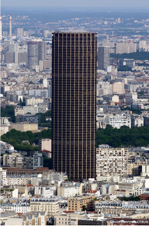
Şekil 2.25. Montparnasse binası, Paris (1973)
